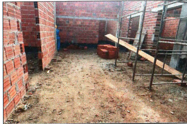
ALVENARIA E VERGAS
