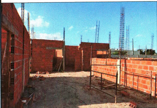
ALVENARIA, PILARES E VERGAS
