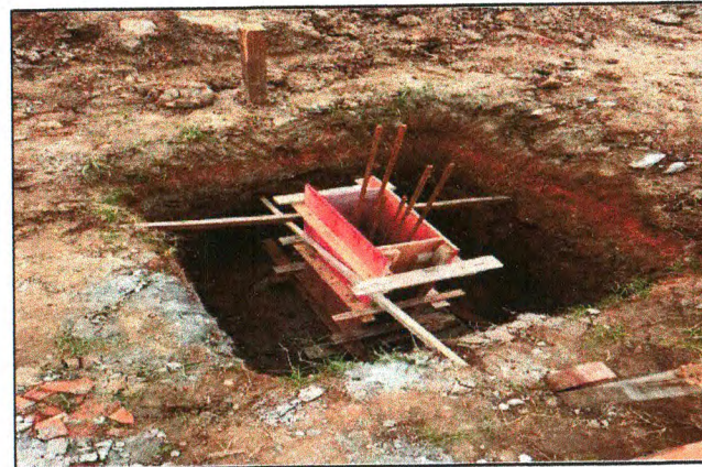
FÔRMA E AÇO DOS ARRANQUES DA GUARITA
