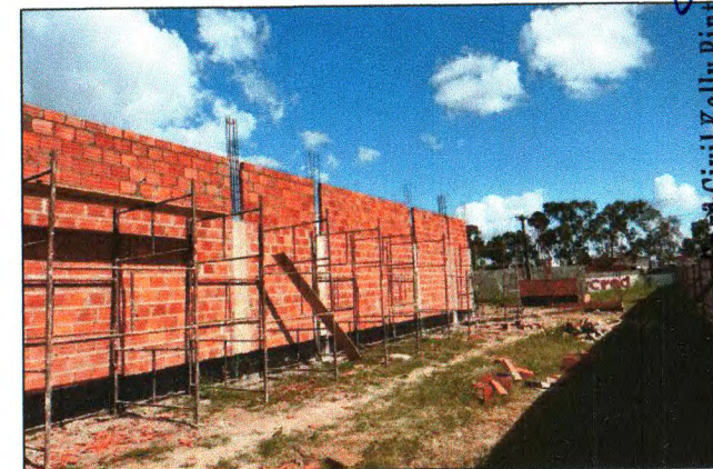
ALVENARIA E PILARES
