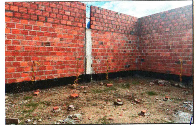
ALVENARIA E PILARES
