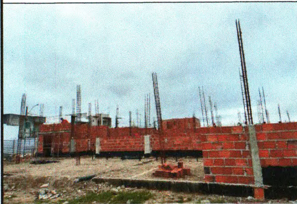
ALVENARIA E PILARES
