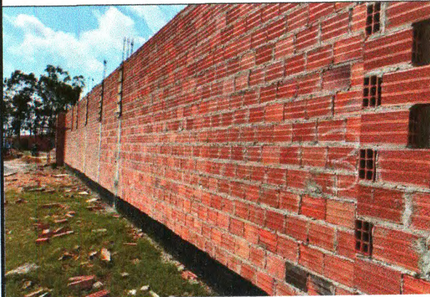
ALVENARIA E FÔRMA DOS PILARES
