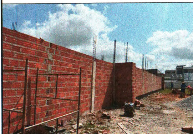
ALVENARIA E PILARES
