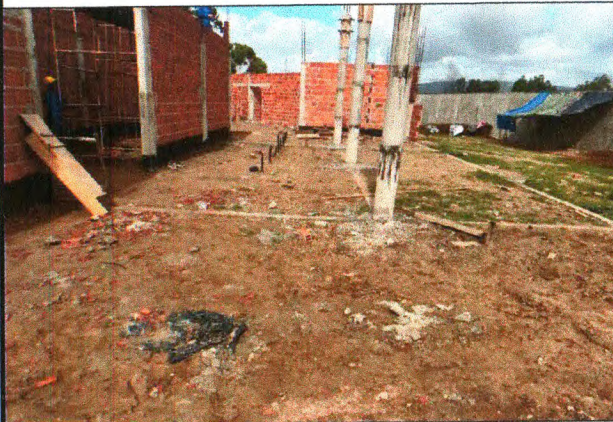
ALVENARIA E PILARES CIRCULARES
