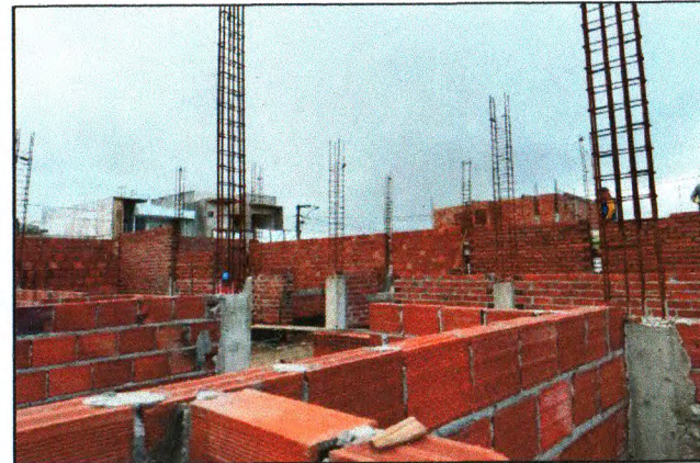
ALVENARIA E PILARES
