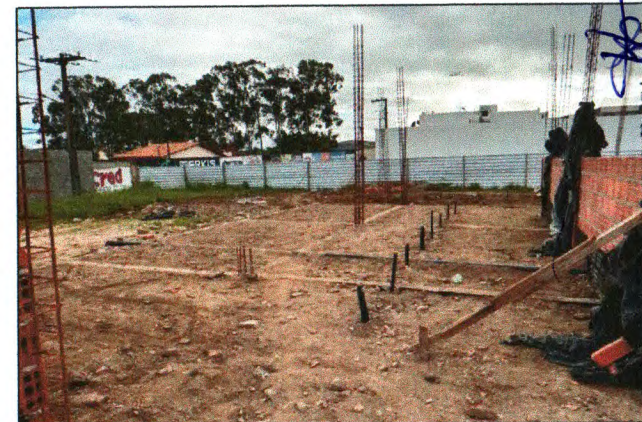
ATERRO, ALVENARIA, CONCRETAGEM DOS PILARES
