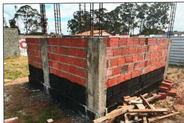
PILARES CONCRETADOS ATÉ 1,5m E IMPERMEABILIZAÇÃO
