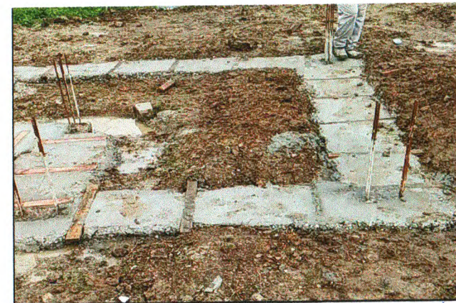
LASTRO DE CONCRETO PARA BALDRAME
