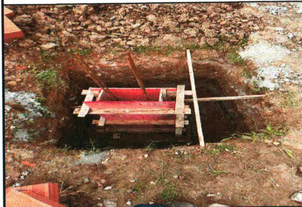
FÔRMA E AÇO DOS ARRANQUES DA GUARITA
