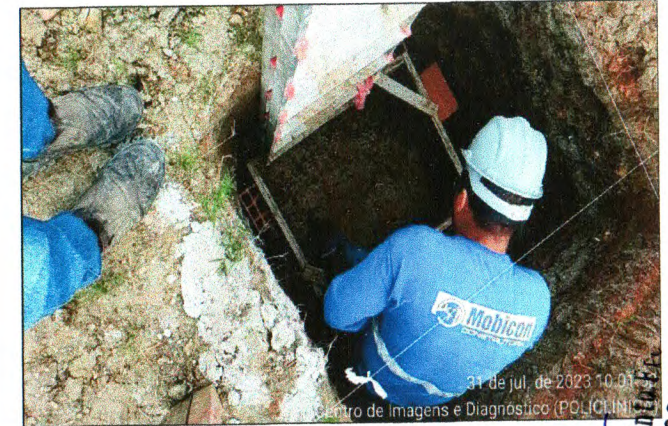
FÔRMA DAS SAPATAS DA GUARITA
