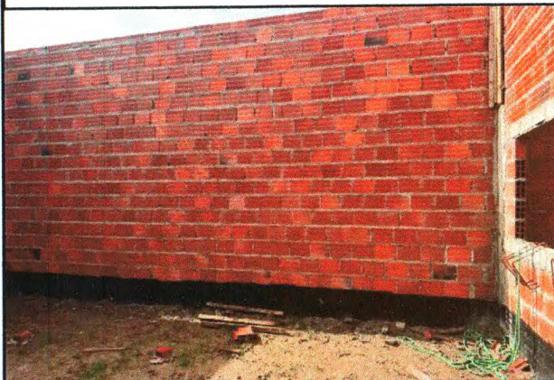
ALVENARIA E PILARES
