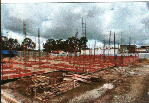
MARCAÇÃO DA ALVENARIA
