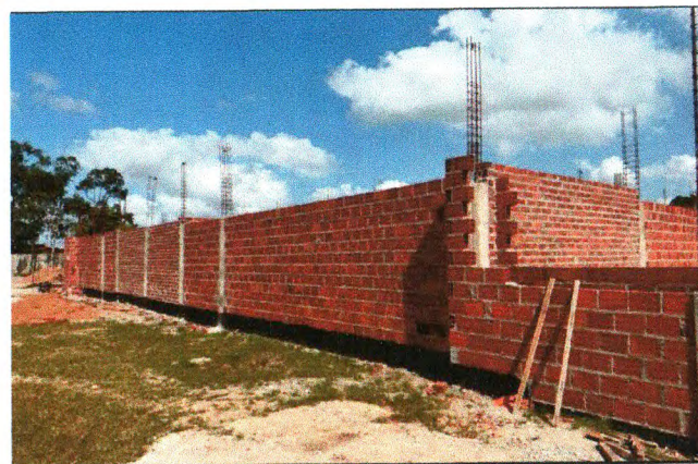
ALVENARIA E PILARES
