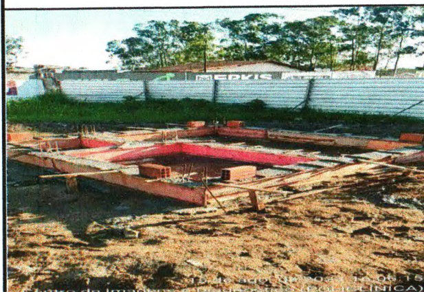
FÔRMA E CONCRETAGEM DO BALDRAME DA GUARITA
