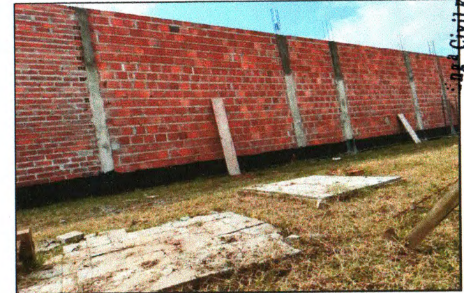
ALVENARIA E PILARES
