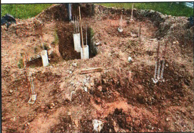
REATERRO DAS SAPATAS DA GUARITA
