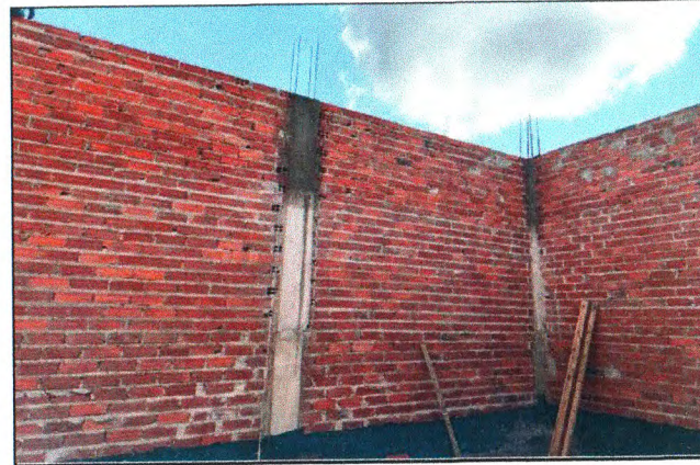
ALVENARIA E PILARES
