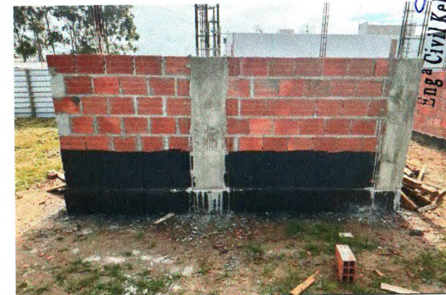
PILARES CONCRETADOS ATÉ 1,5m E IMPERMEABILIZAÇÃO
