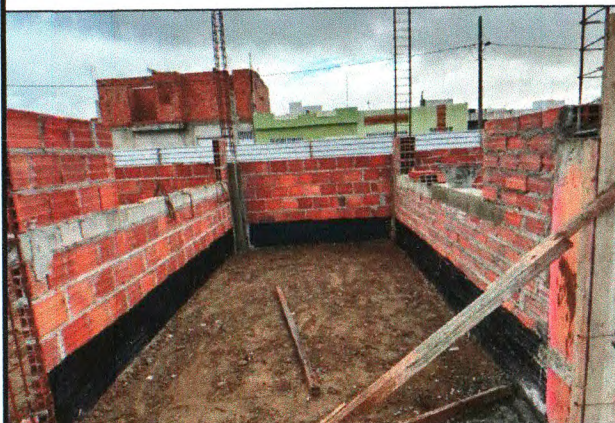
ALVENARIA, CONTRAVERGA, ATERRO
