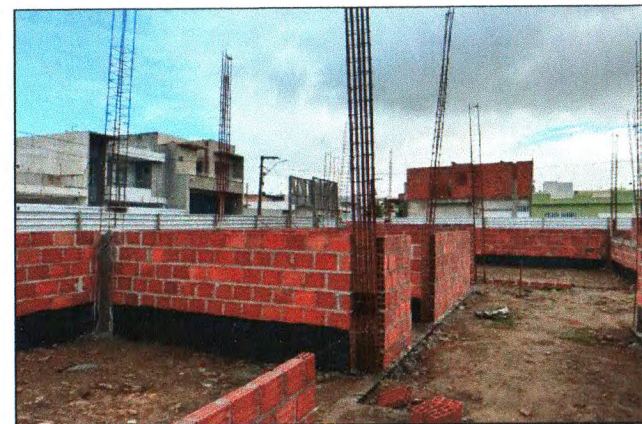
ALVENARIA, ATERRO, CONCRETAGEM DOS PILARES
