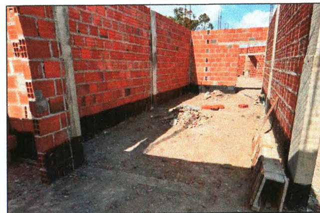
ALVENARIA E PILARES
