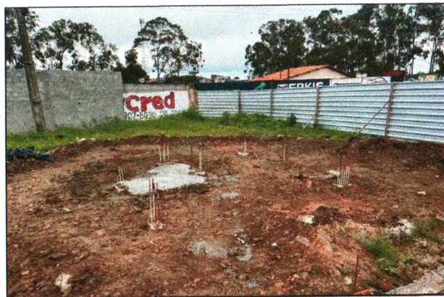
REATERRO DAS SAPATAS DA GUARITA
