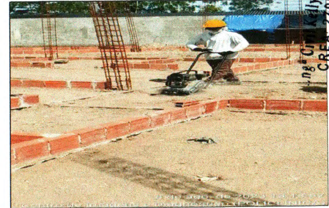
COMPACTAÇÃO DO ATERRO
