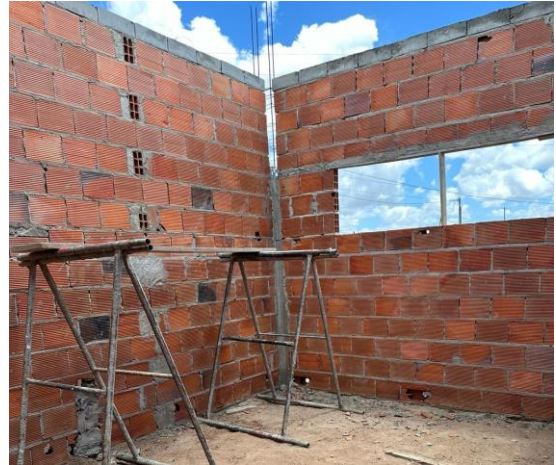
ALVENARIA, PILARES E CINTAMENTO SUP.
