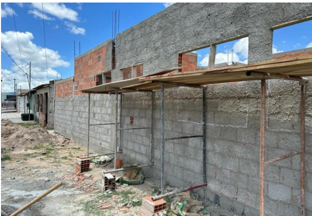
CHAPISCO, ALVENARIA E PILARES
