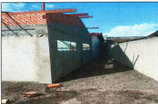
EMASSAMENTO DE BEIRAL
