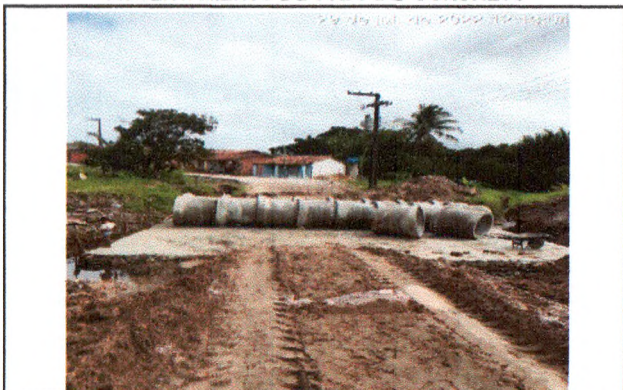
ASSENTAMENTO DE TUBO DE CONCRETO
