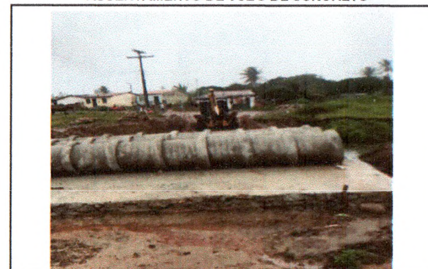
ASSENTAMENTO DE TUBO DE CONCRETO
