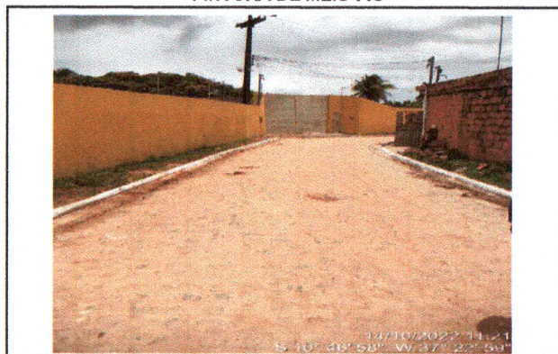
PINTURA DE MEIO-FIO
