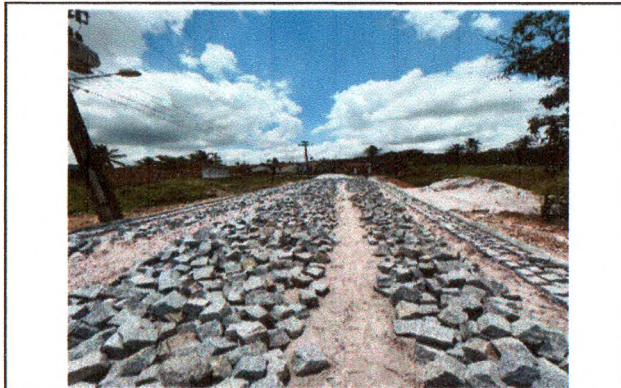
PAVIMENTAÇÃO EM PARALELEPÍEDO
