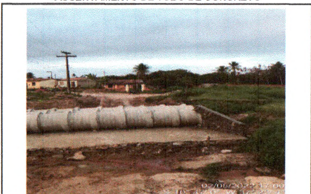
ASSENTAMENTO DE TUBO DE CONCRETO
