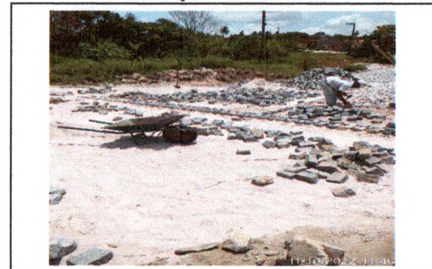
PAVIMENTAÇÃO EM PARALELEPÍEDO
