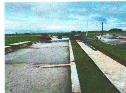
LONA PLÁSTICA, PISO EM CONCRETO, GRAMA E BANCO DE CONCRETO NO MARCO JOÃO DE DEUS SOUSA
