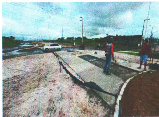
LONA PLÁSTICA, PISO EM CONCRETO, PAVIMENTAÇÃO EM CONCRETO E CONCRETO SIMPLES NA ROTATÓRIA 01
