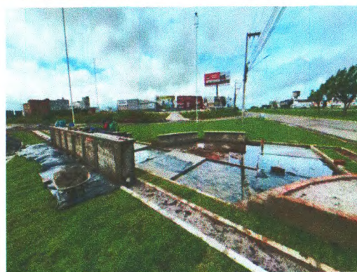
ATERRO, ALVENARIA, CHAPISCO, REBOCO E CONCRETO E GRAMA NO BUSTO JOÃO DE DEUS SOUSA
