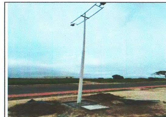
INSTALAÇÕES ELETRICAS DA AVENIDA JOÃO DE DEUS SOUSA
