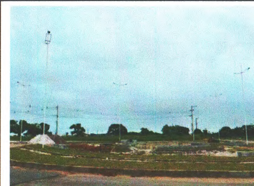
GRAMA E BANCO DE CONCRETO NA ROTATÓRIA 02
