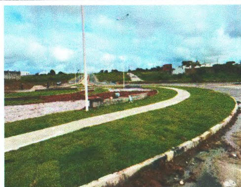
CONCRETO SIMPLES, LONA E PISO EM CONCRETO NA ROTATÓRIA 03
