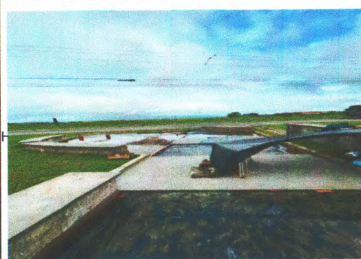
ATERRO, ALVENARIA, CHAPISCO, REBOCO E CONCRETO, GRAMA E BANCO DE CONCRETO NO BUSTO JOÃO DE DEUS SOUSA
