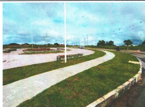
CONCRETO SIMPLES, LONA E PISO EM CONCRETO NA ROTATÓRIA 02
