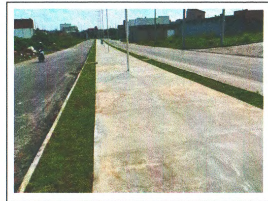
FALTA FOTO DA GRAMA DO CANTEIRO 04
