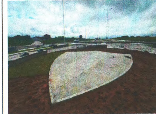
ALVENARIA, CHAPISCO, REBOCO, ATERRO, CONCRETO SIMPLES E GRAMA NA ROTATÓRIA 01
