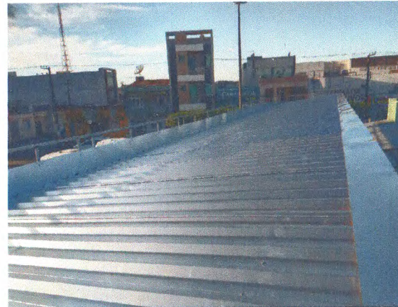
Telhamento, calha e rufo metálicos
