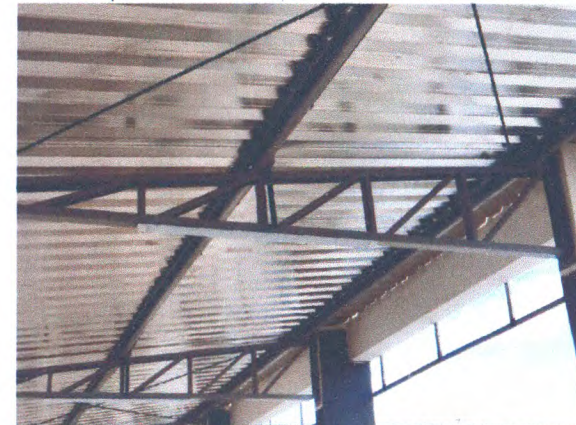
Telha metálica; Estrutura treliçada da cobertura; Terças metálicas; Pintura sobre superfícies metálicas; Estrutura em concreto armado; Pintura com emassamento acrílico
