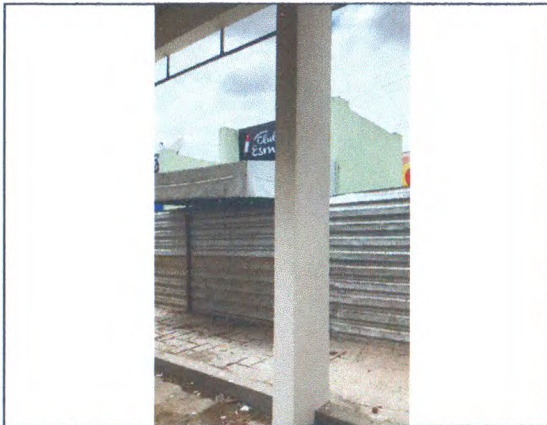
Estrutura em concreto armado; Pintura com emassamento acrílico
