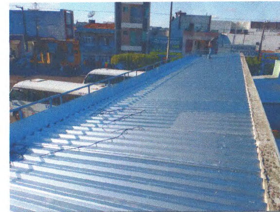
Telhamento e calha metálicos
