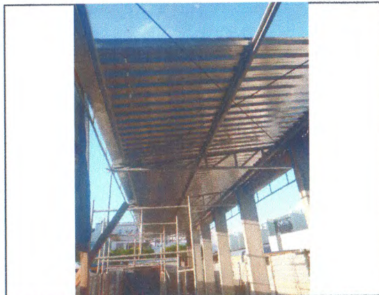
Telha metálica; Estrutura treliçada da cobertura; Terças metálicas; Pintura sobre superfícies metálicas; Estrutura em concreto armado; Calha metálica
