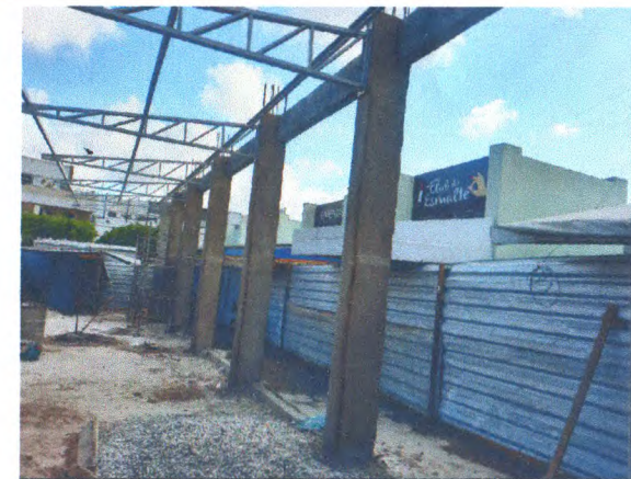
Estrutura treliçada da cobertura; Terças metálicas; Pintura sobre superfícies metálicas; Estrutura em concreto armado
