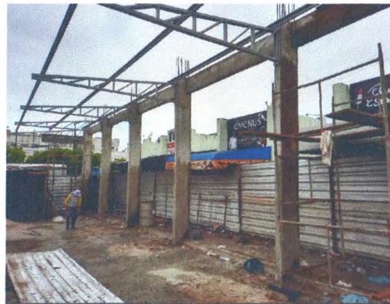
Estrutura treliçada da cobertura; Terças metálicas; Pintura sobre superfícies metálicas; Estrutura em concreto armado
