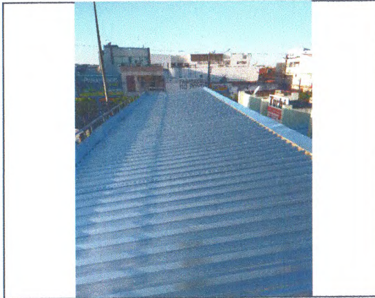
Telhamento, calha e rufo metálicos
