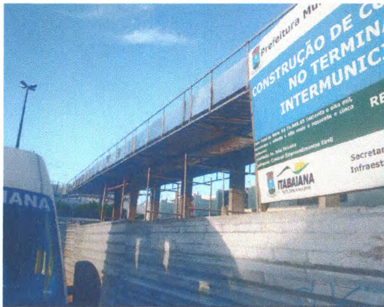
Estrutura treliçada da cobertura; Terças metálicas; Pintura sobre superfícies metálicas; Calha metálica; Placa da obra
