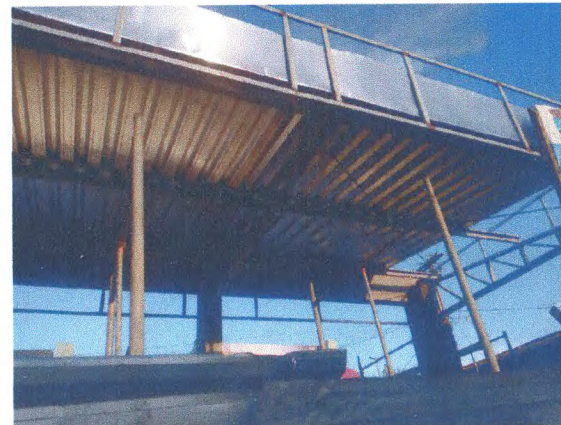
Telha metálica; Estrutura treliçada da cobertura; Terças metálicas; Pintura sobre superfícies metálicas; Estrutura em concreto armado; Calha metálica
