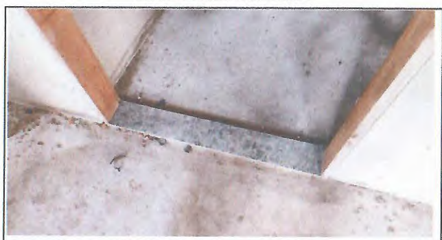
CONTRA PISO E SOLEIRA
