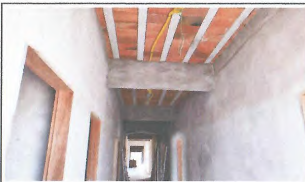
REBOCO, INSTALAÇÕES ELÉTRICAS E BATENTE PORTA
