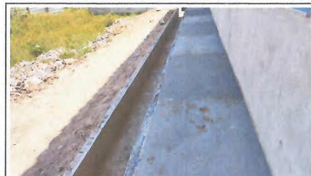
PISO CIMENTADO E CALHA
