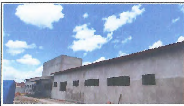
REBOCO E TELhado
