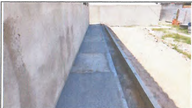
PISO CIMENTADO E CALHA
