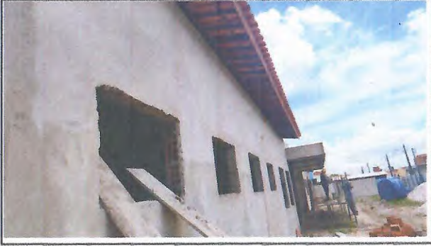
REBOCO, MADEIRAMENTO E TELHAMENTO
