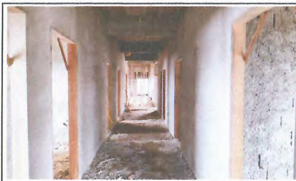
REBOCO E BATENTE DAS PORTAS
