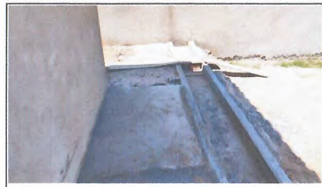
PISO CIMENTADO E CALHA
