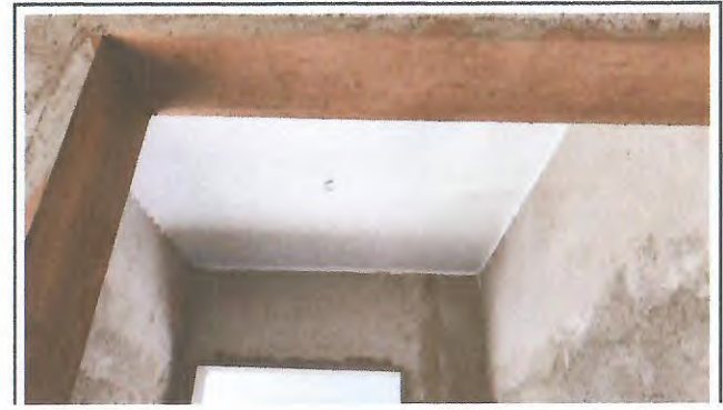
BATENTE E REBOCO
