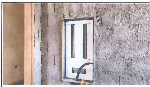
REBOCO, INSTALAÇÕES ELÉTRICAS E BATENTE PORTA
