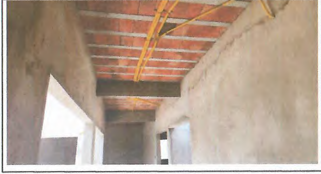
REBOCO E ENSTALAÇÕES ELÉTRICAS
