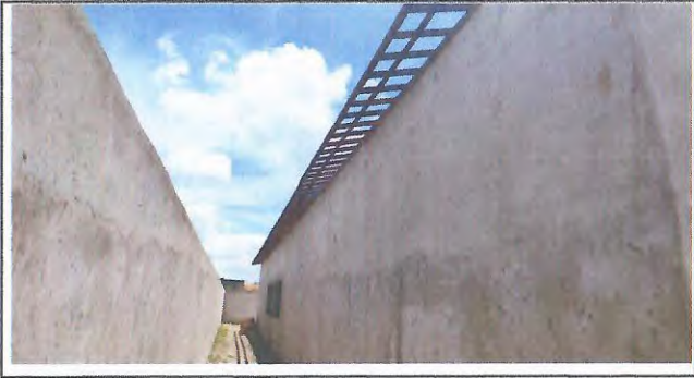
REBOCO E MADEIRAMENTO
