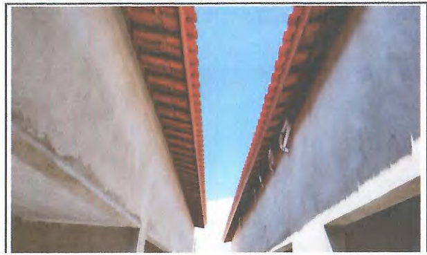
MURO E REBOCO EXTERNO
