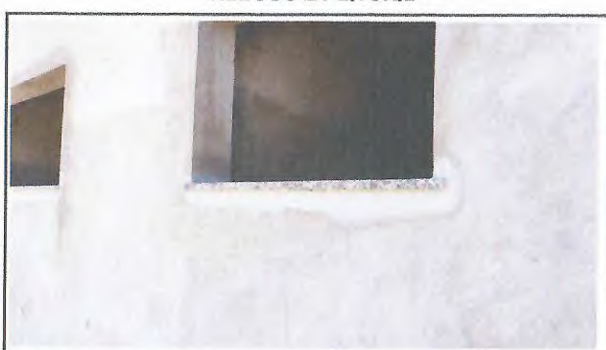
REBOCO E PEITORIL
