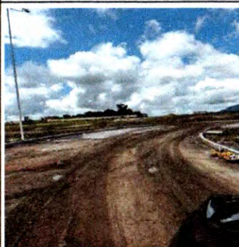
MEIO FIO, POSTES E LUMINÁRIAS
