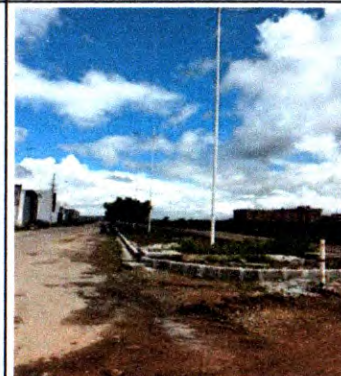
MEIO FIO, POSTES E LUMINÁRIAS
