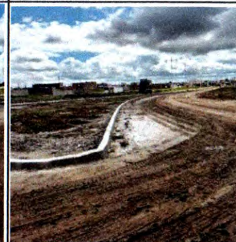
MEIO FIO, POSTES E LUMINÁRIAS, MOVIMENTAÇÃO DE TERRA E ATERRO
