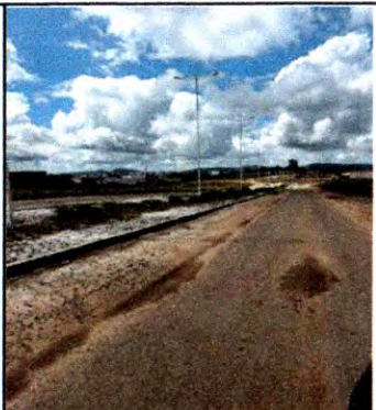
MEIO FIO, POSTES E LUMINÁRIAS, MOVIMENTAÇÃO DE TERRA E ATERRO
