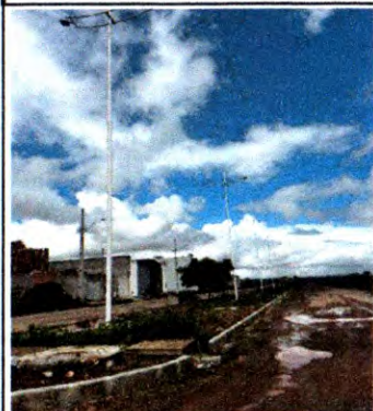
MEIO FIO, POSTES E LUMINÁRIAS
