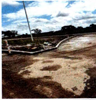
MEIO FIO, POSTES E LUMINÁRIAS, MOVIMENTAÇÃO DE TERRA
