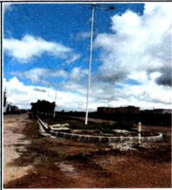
MEIO FIO, POSTES E LUMINÁRIAS
