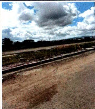
MEIO FIO, POSTES E LUMINÁRIAS, MOVIMENTAÇÃO DE TERRA
