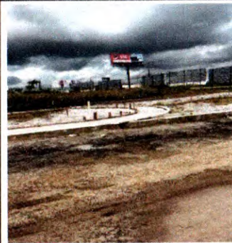
MEIO FIO, POSTES E LUMINÁRIAS, MOVIMENTAÇÃO DE TERRA E ATERRO
