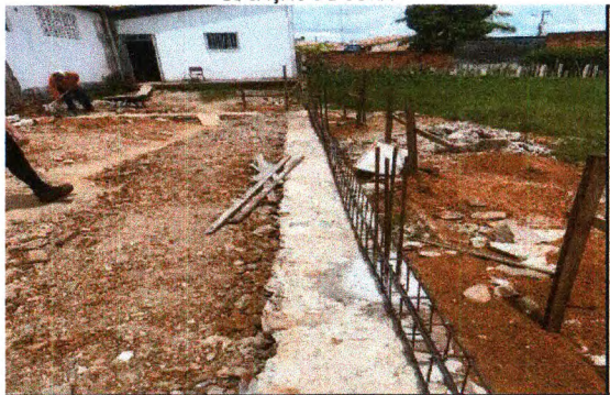
ALVENARIA DE PEDRA
