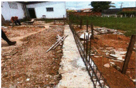
LOCAÇÃO DE OBRA
