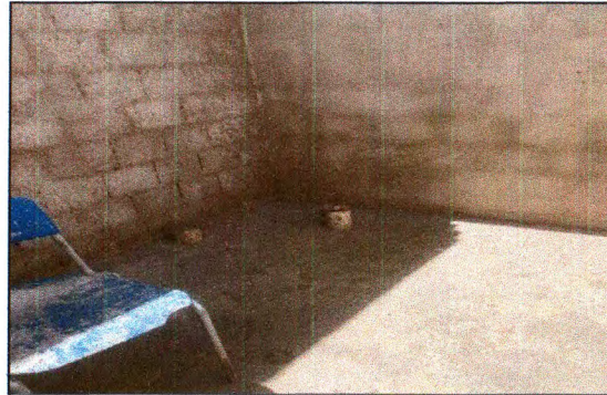
PONTO DE ESGOTO
