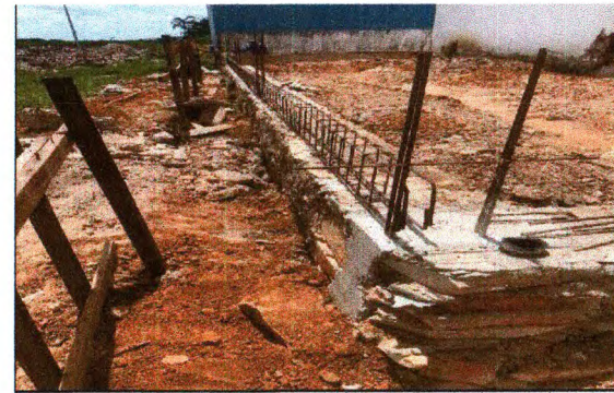
ALVENARIA DE PEDRA
