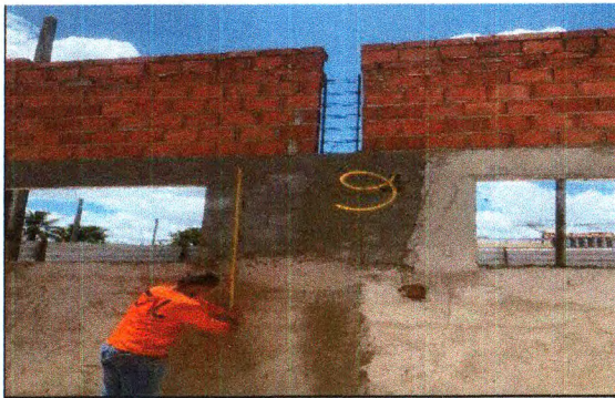
ALVENARIA DE BLOCO
