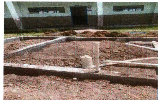
PONTO DE ESGOTO
