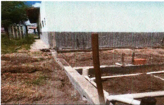
PONTO DE ESGOTO
