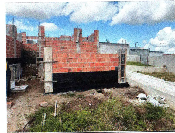
ELEVAÇÃO DA ALVENARIA E CONCRETAGEM DE PILARES E PINTURA IMPERMEABILIZANTE
