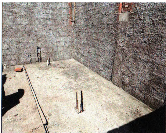
PONTOS DE AR COMPRIMIDO E CHAPISCO
