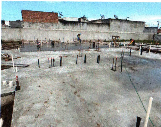
CAMADA IMPERMEABILIZADORA, INSTALAÇÕES DE LÓGICA E SANITÁRIAS
