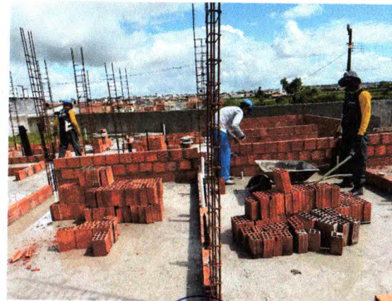
ELEVAÇÃO DA ALVENARIA
