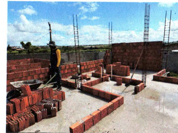
ELEVAÇÃO DA ALVENARIA
