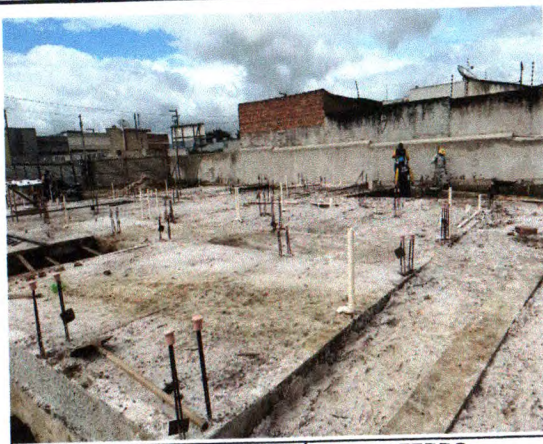
INSTALAÇÕES SANITÁRIAS E ATERRO
