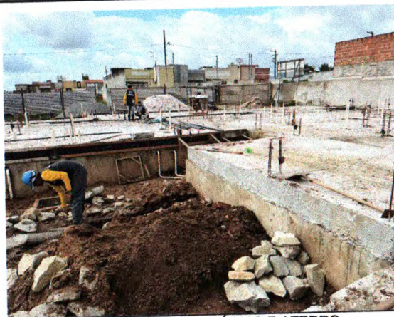
INSTALAÇÕES SANITÁRIAS E ATERRO
