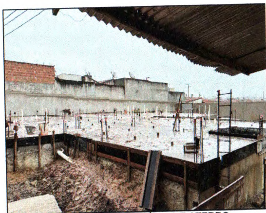
INSTALAÇÕES SANITÁRIAS E ATERRO
