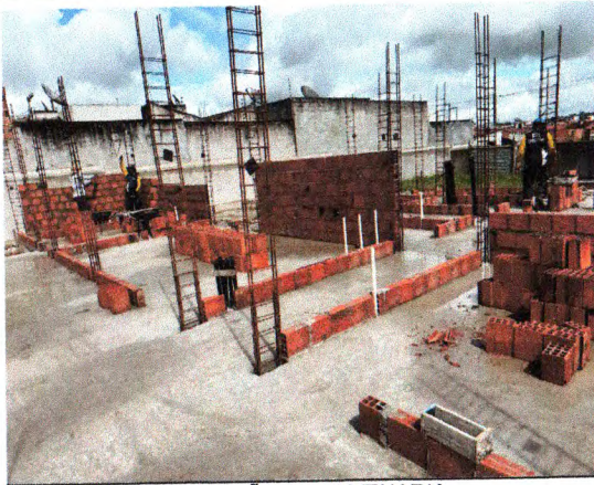
ELEVAÇÃO DA ALVENARIA
