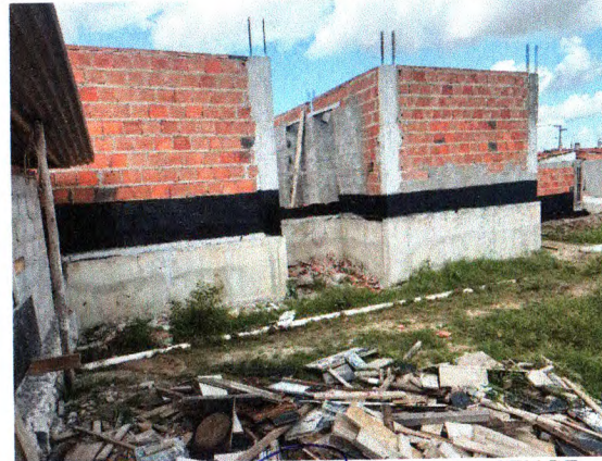
ELEVAÇÃO DA ALVENARIA E CONCRETAGEM DE PILARES E PINTURA IMPERMEABILIZANTE
