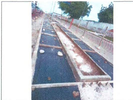
TAPUME DE PROTEÇÃO EM TELA; MEIO-FIO EM CONCRETO; ATERRO COMPACTADO; LONA PLÁSTICA
