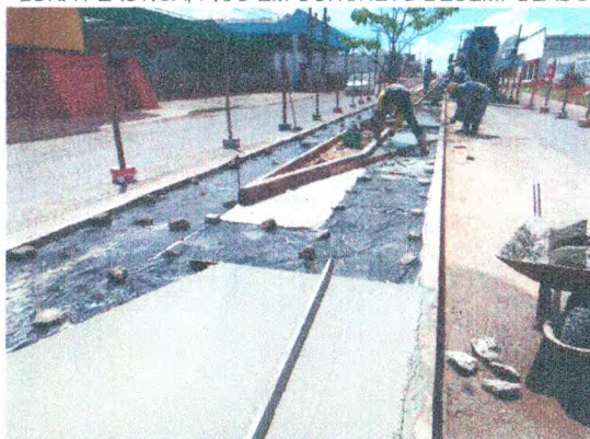
TAPUME DE PROTEÇÃO EM TELA; MEIO-FIO EM CONCRETO; ATERRO COMPACTADO; LONA PLÁSTICA; PISO EM CONCRETO DESEMPOLADO
