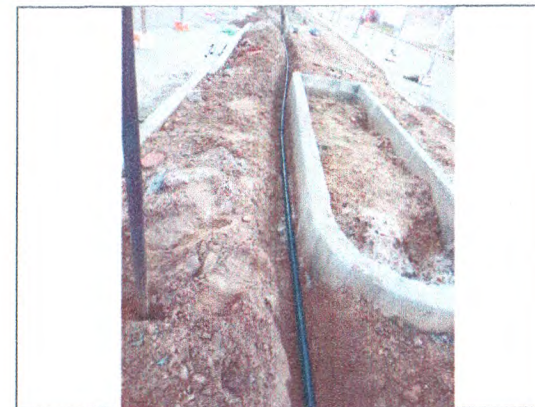
ESCAVAÇÃO; MEIO-FIO EM CONCRETO; ELETRODUTOS DE PVC
