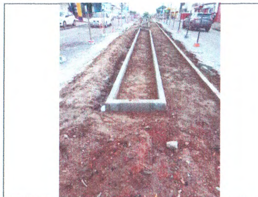
TAPUME DE PROTEÇÃO EM TELA; ASSENTAMENTO DE MEIO-FIO EM CONCRETO; ESCAVAÇÃO
