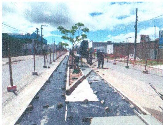
MEIO-FIO EM CONCRETO; ATERRO COMPACTADO; LONA PLÁSTICA; PISO EM CONCRETO
