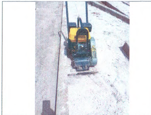
MEIO-FIO EM CONCRETO; ATERRO COMPACTADO
