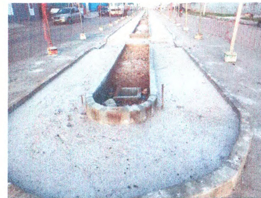
TAPUME DE PROTEÇÃO EM TELA; MEIO-FIO EM CONCRETO; ATERRO COMPACTADO
