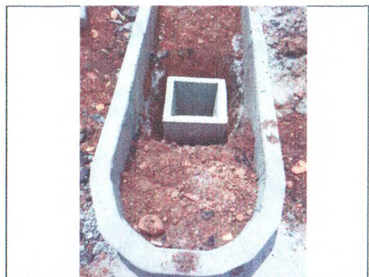
ESCAVAÇÃO; MEIO-FIO EM CONCRETO; CAIXA DE PASSAGEM
