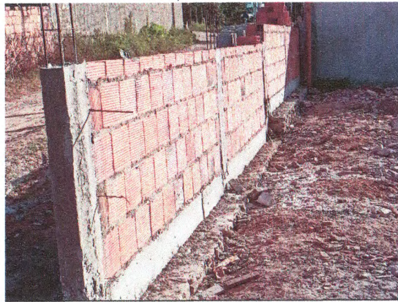
MURO - CINTAMENTO; PILARES EM CONCRETO ARMADO; ALVENARIA DE BLOCO
