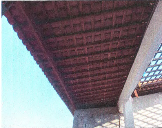
COBERTURA - MADEIRAMENTO E TELHAMENTO NOVOS
