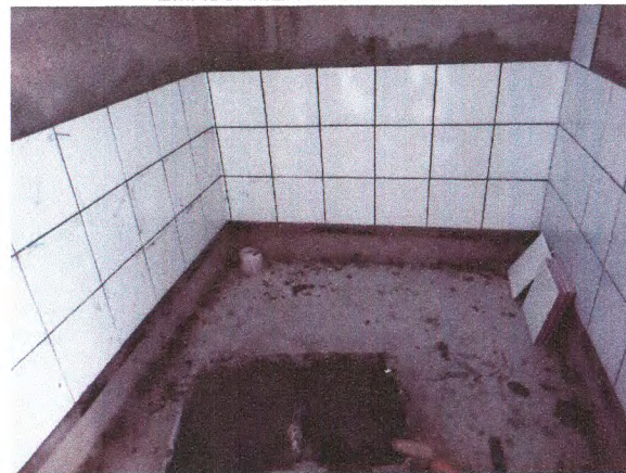
BANHEIRO - ASSENTAMENTO DO REVESTIMENTO CERÂMICO; PONTO DE ESGOTO
