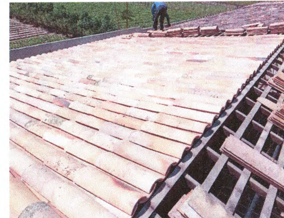
COBERTURA - REVISÃO; LAVAGEM DAS TELHAS
