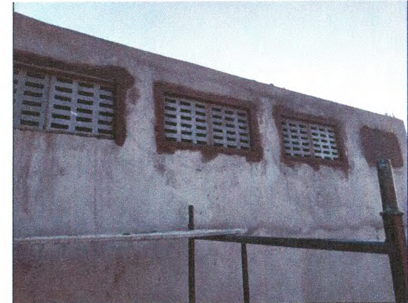
BANHEIROS - REBOCO EXTERNO; COMBOGÓ DE CIMENTO
