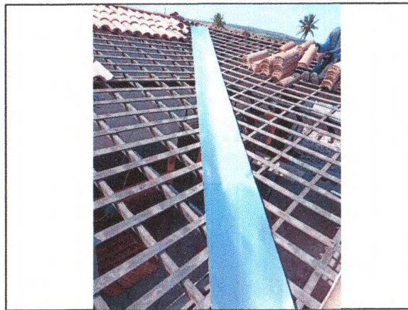
COBERTURA - REVISÃO; LAVAGEM DAS TELHAS; CALHA EM CHAPA DE AÇO GALVANIZADO
