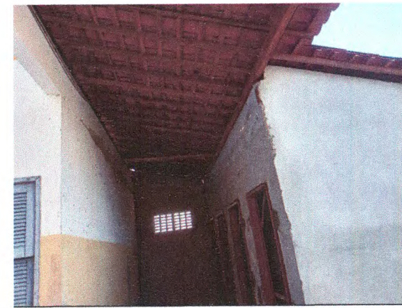
COBERTURA - MADEIRAMENTO E TELHAMENTO NOVOS
