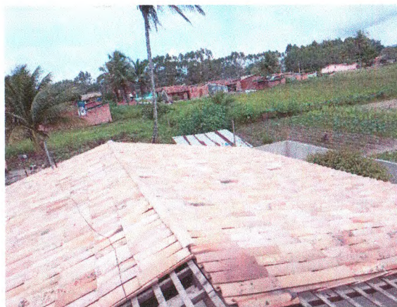
COBERTURA - REVISÃO; LAVAGEM DAS TELHAS
