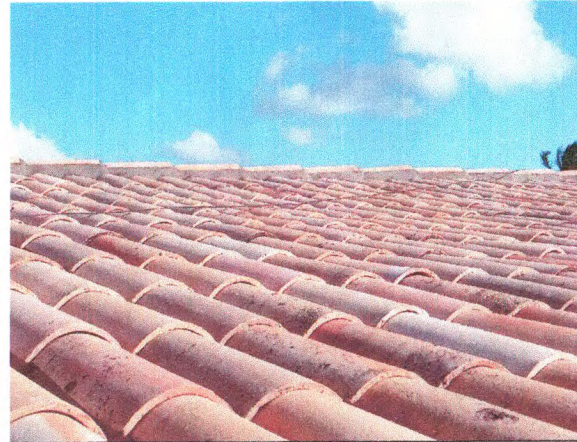
COBERTURA - REVISÃO; LAVAGEM DAS TELHAS; EMASSAMENTO DE CUMEEIRA
