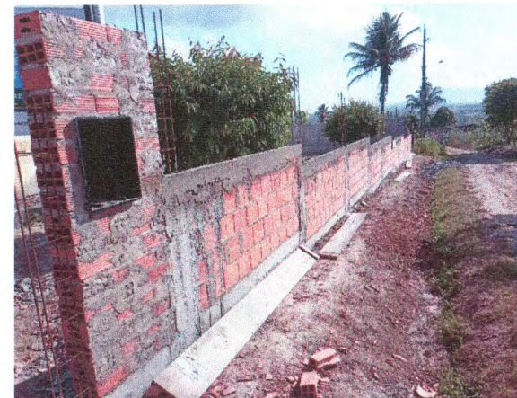
MURO - CINTAMENTO; PILARES EM CONCRETO ARMADO; ALV. DE BLOCO; QUADRO DE MEDIÇÃO
