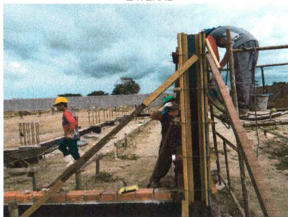
CONCRETAGEM DOS PILARES DO MURO FRONTAL; ATERRO DO CAIXÃO DA EDIFICAÇÃO BLOCO B
