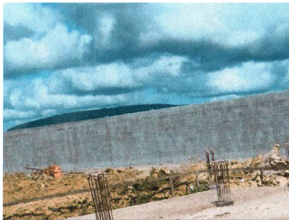
CHAPISCO NA ALVENARIA CERÂMICA DO MURO LATERAL
