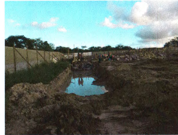
ESCAVAÇÃO; ALVENARIA DE PEDRA ARGAMASSADA; MATERIAL DE SUB-BASE
