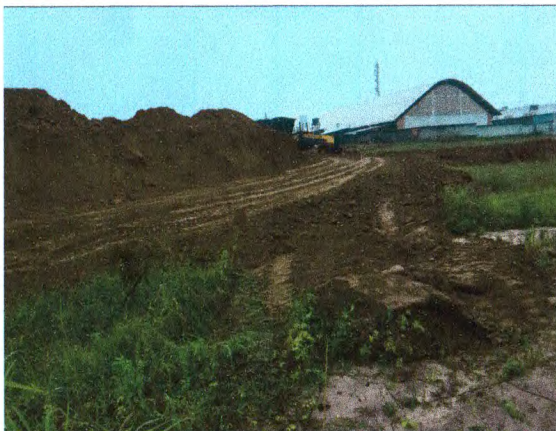
TRANSPORTE; ESPALHAMENTO E COMPACTAÇÃO DE MATERIAL DE SUB-BASE
