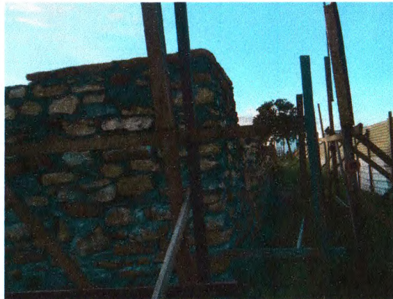
ASSENTAMENTO DA ALVENARIA DE PEDRA NO MURO LATERAL
