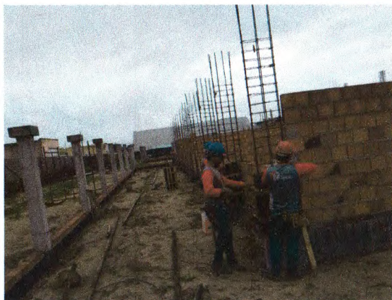
IMPERMEABILIZAÇÃO DAS VIGAS; ALVENARIA DE BLOCO CERÂMICO; FERRAGEM E FORMA DOS PILARES DO BLOCO B
