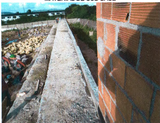
ALVENARIA DE PEDRA ARGAMASSADA; IMPERMEABILIZAÇÃO DA VIGA BALDRAME; ALVENARIA DE BLOCO CERÂMICO DO MURO LATERAL
