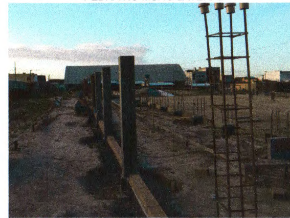
CONCRETAGEM DOS PILARES DO MURO FRONTAL
