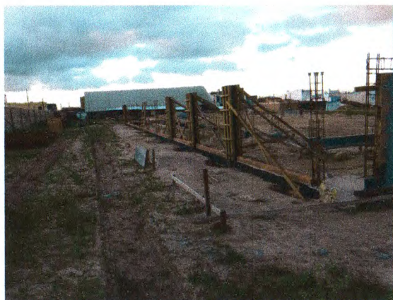
CINTAMENTO INFERIOR; MONTAGEM DAS FORMAS DOS PILARES NO MURO FRONTAL
