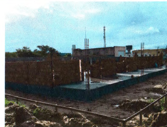
IMPERMEABILIZAÇÃO DAS VIGAS; ALVENARIA DE BLOCO CERÂMICO NO BLOCO B
