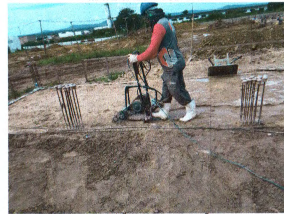
ATERRO DO CAIXÃO DA EDIFICAÇÃO BLOCO B; FERRAGEM DOS ARRANQUES DOS PILARES DO BLOCO B
