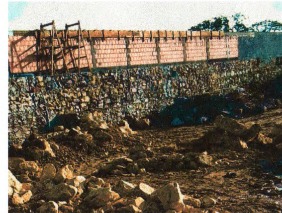
ALVENARIA CERÂMICA SOBRE BASE DE ALVENARIA DE PEDRA NO MURO LATERAL
