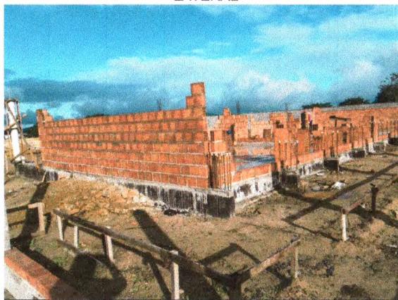
IMPERMEABILIZAÇÃO DAS VIGAS; ALVENARIA DE BLOCO CERÂMICO; FERRAGEM DO BLOCO B
