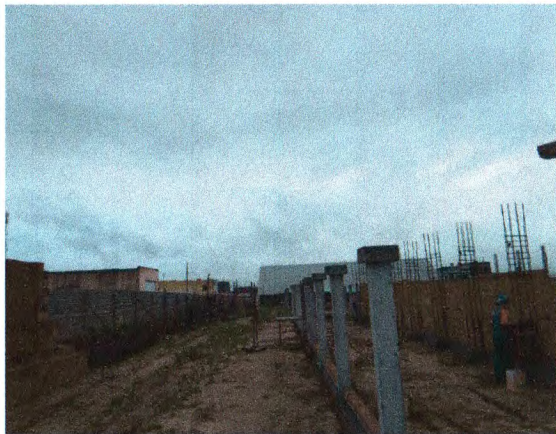
CONCRETAGEM DOS PILARES DO MURO FRONTAL
