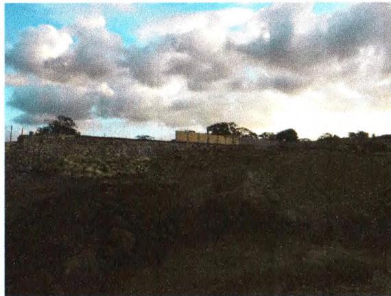
ALVENARIA DE PEDRA ARGAMASSADA; MATERIAL DE SUB-BASE
