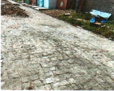
RUA JOSIVALDO DOS SANTOS
