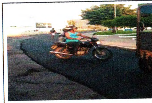
RECAPEAMENTO DA AVENIDA PADRE AIRTON GONÇALVES
