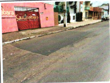
RECUPERAÇÃO PAV. ASFÁTICA (AV. DOUTOR LUIZ MAGALHÃES E PROXIMIDADES)
