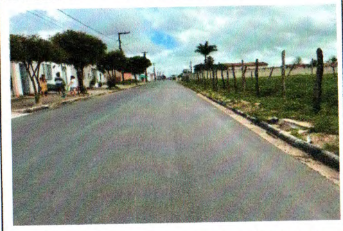
RECAPEAMENTO DA AVENIDA PADRE AIRTON GONÇALVES
