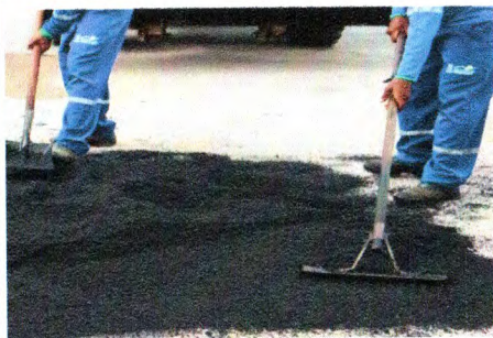
RECUPERAÇÃO PAV. ASFÁTICA (RUA JACKSON DE FIGUEIREDO E PROXIMIDADES)
