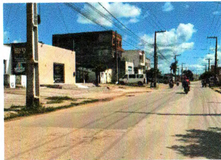
RECUPERAÇÃO PAV. ASFÁTICA (AV. ZEFINHA DE CAPITULINO E PROXIMIDADES)
