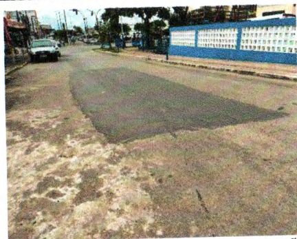
RECUPERAÇÃO PAV. ASFÁTICA (AVENIDA JOÃO TEIXEIRA E PROXIMIDADES)
