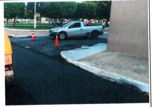
RECAPEAMENTO DA AVENIDA PADRE AIRTON GONÇALVES
