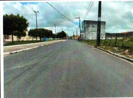
RECAPEAMENTO DA AVENIDA PADRE AIRTON GONÇALVES
