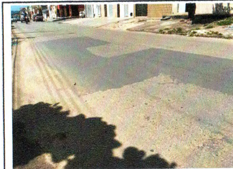
RECUPERAÇÃO PAV. ASFÁTICA (RUA PERCÍLIO ANDRADE E PROXIMIDADES)
