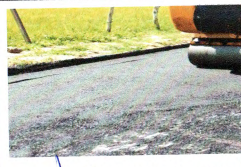
RECAPEAMENTO DA AVENIDA PADRE AIRTON GONÇALVES
