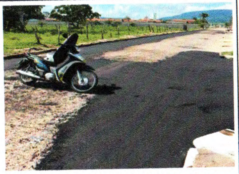
RECAPEAMENTO DA AVENIDA PADRE AIRTON GONÇALVES
