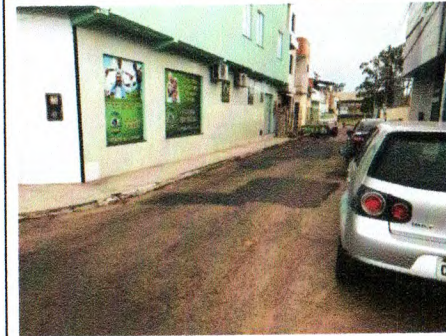
RECUPERAÇÃO PAV. ASFÁTICA (RUA GENERAL CALAZANS E PROXIMIDADES)
