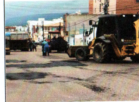
RECUPERAÇÃO PAV. ASFÁTICA (RUA MONSENHOR ERALDO BARBOSA E PROXIMIDADES)
