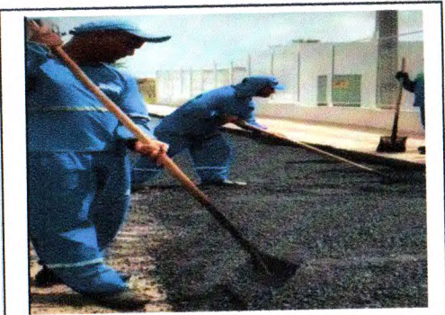
RECAPEAMENTO DA AVENIDA PADRE AIRTON GONÇALVES
