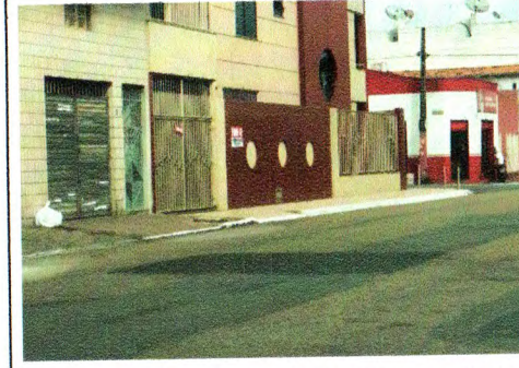
RECUPERAÇÃO PAV. ASFÁTICA (RUA BOANERGES PINHEIRO E PROXIMIDADES)
