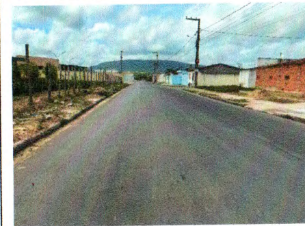
RECAPEAMENTO DA AVENIDA PADRE AIRTON GONÇALVES
