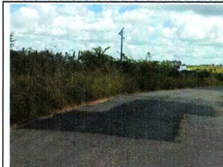
RECUPERAÇÃO PAV. ASFÁTICA BAIRRO QUEIMADAS
