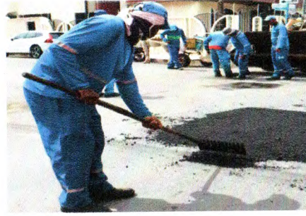
RECUPERAÇÃO PAV. ASFÁTICA (RUA JACKSON DE FIGUEIREDO E PROXIMIDADES)
