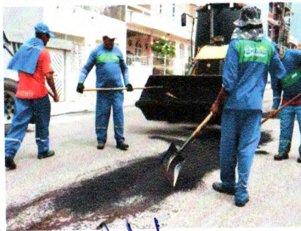
RECUPERAÇÃO PAV. ASFÁTICA (RUA MONSENHOR ERALDO BARBOSA E PROXIMIDADES)
