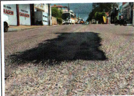
RECUPERAÇÃO PAV. ASFÁTICA (RUA MONSENHOR ERALDO BARBOSA E PROXIMIDADES)
