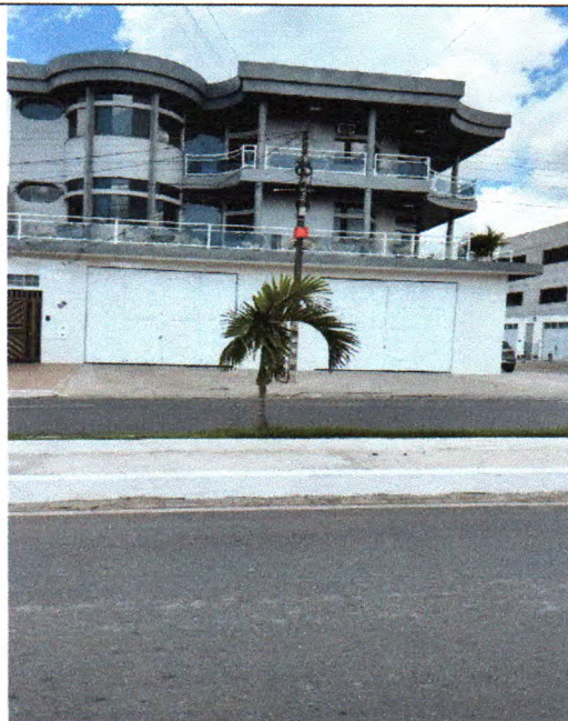
Figura 18: Fornecimento e espalhamento de terra vegetal em alguns canteiros, replantio de: gramas, palmeiras, Ipês e arbustos como também limpeza da avenida João Teixeira
