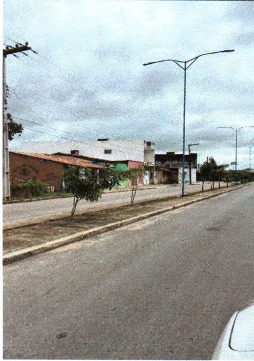
Figura 16: Fornecimento e espalhamento de terra vegetal, plantio de gramas, palmeiras, Ipês e arbustos como também limpeza final da avenida do Riacho Doce
