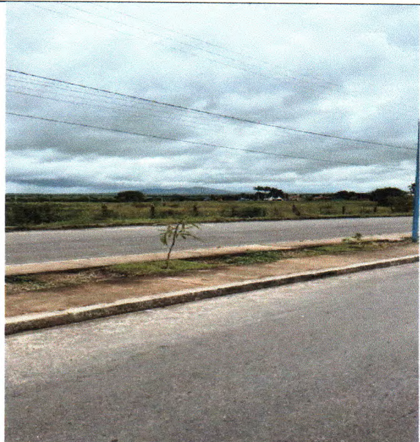
Figura 08: Fornecimento e espalhamento de terra vegetal, plantio de gramas, palmeiras, Ipês e arbustos como também limpeza final da avenida do Riacho Doce
