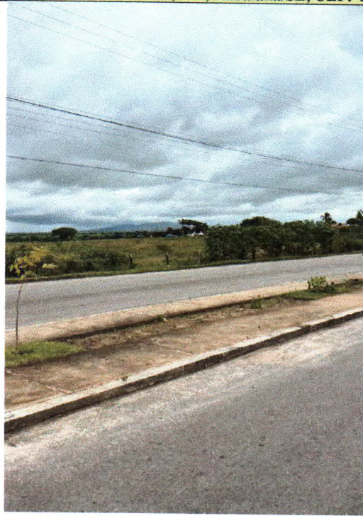
Figura 08: Fornecimento e espalhamento de terra vegetal, plantio de gramas, palmeiras, Ipês e arbustos como também limpeza final da avenida do Riacho Doce
