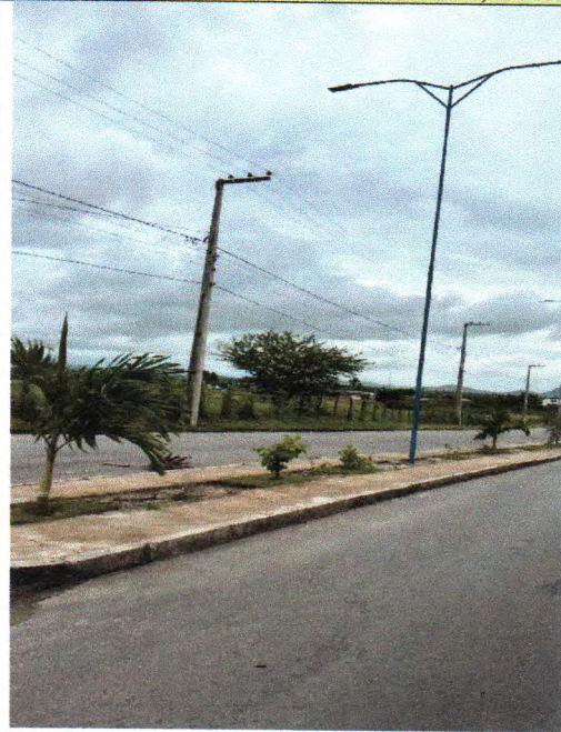
Figura 05: Fornecimento e espalhamento de terra vegetal, plantio de gramas, palmeiras, Ipês e arbustos como também limpeza final da avenida do Riacho Doce
