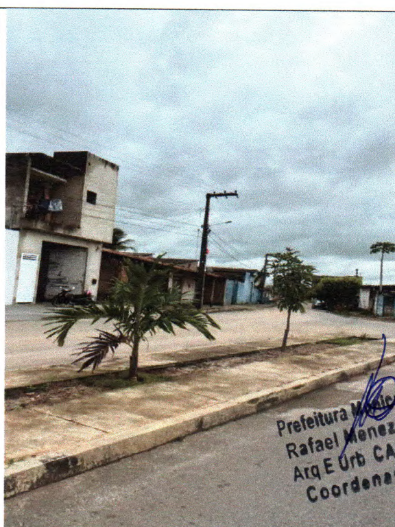
Figura 15: Fornecimento e espalhamento de terra vegetal, plantio de gramas, palmeiras, Ipês e arbustos como também limpeza final da avenida do Riacho Doce
