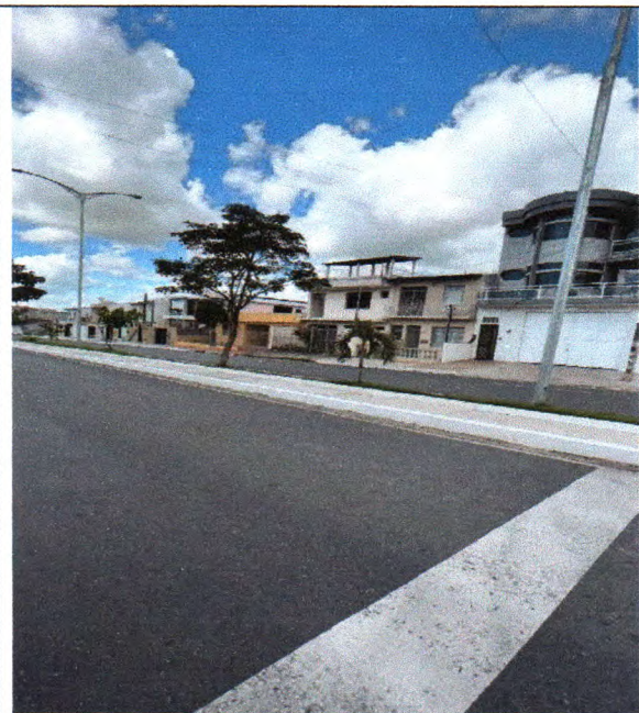
Figura 19: Fornecimento e espalhamento de terra vegetal em alguns canteiros, replantio de: gramas, palmeiras, Ipês e arbustos como também limpeza da avenida João Teixeira
