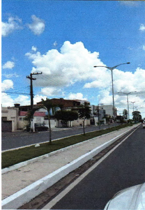
Figura 20: Fornecimento e espalhamento de terra vegetal em alguns canteiros, replantio de: gramas, palmeiras, Ipês e arbustos como também limpeza da avenida João Teixeira
