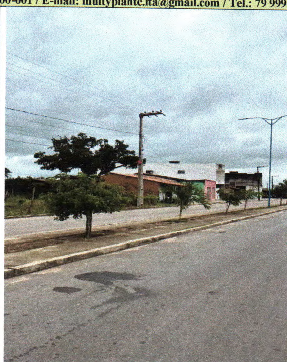
Figura 13: Fornecimento e espalhamento de terra vegetal, plantio de gramas, palmeiras, Ipês e arbustos como também limpeza final da avenida do Riacho Doce
