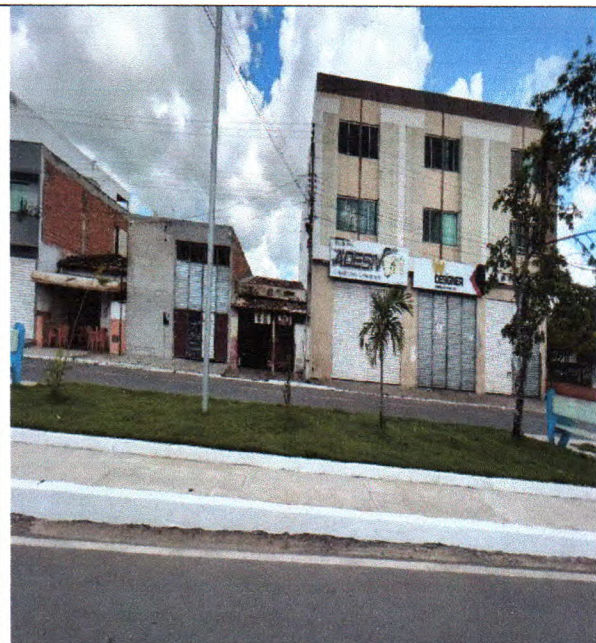
Figura 23: Fornecimento e espalhamento de terra vegetal em alguns canteiros, replantio de: gramas, palmeiras, Ipês e arbustos como também limpeza da avenida João Teixeira
