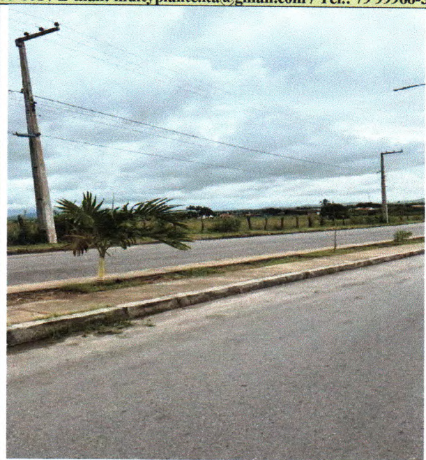
Figura 06: Fornecimento e espalhamento de terra vegetal, plantio de gramas, palmeiras, Ipês e arbustos como também limpeza final da avenida do Riacho Doce
