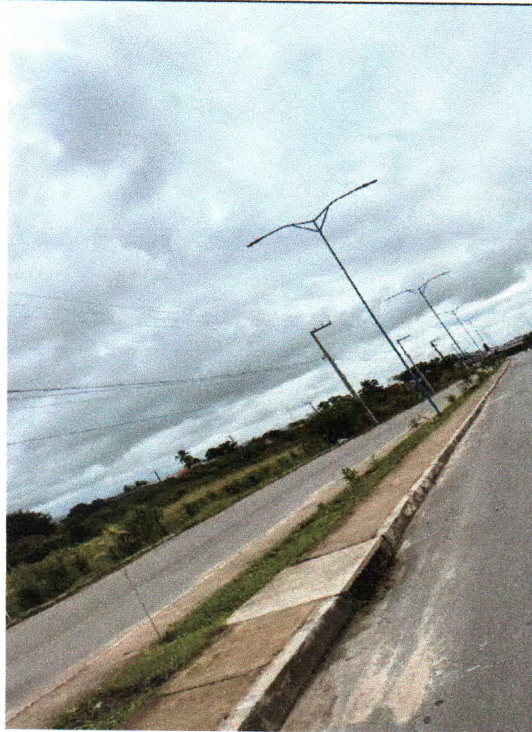
Figura 10: Fornecimento e espalhamento de terra vegetal, plantio de gramas, palmeiras, Ipês e arbustos como também limpeza final da avenida do Riacho Doce
