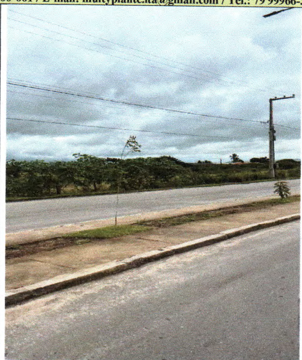
Figura 09: Fornecimento e espalhamento de terra vegetal, plantio de gramas, palmeiras, Ipês e arbustos como também limpeza final da avenida do Riacho Doce
