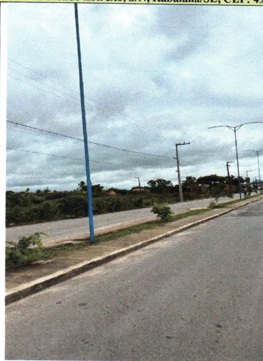
Figura 12: Fornecimento e espalhamento de terra vegetal, plantio de gramas, palmeiras, Ipês e arbustos como também limpeza final da avenida do Riacho Doce
