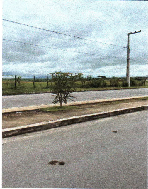
Figura 07: Fornecimento e espalhamento de terra vegetal, plantio de gramas, palmeiras, Ipês e arbustos como também limpeza final da avenida do Riacho Doce
