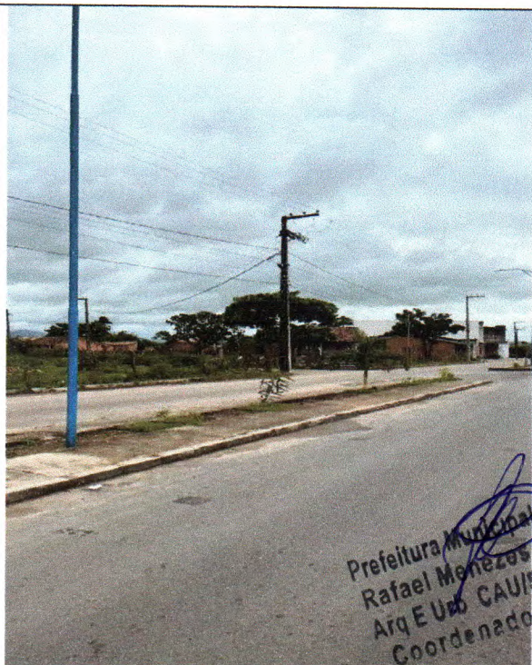
Figura 11: Fornecimento e espalhamento de terra vegetal, plantio de gramas, palmeiras, Ipês e arbustos como também limpeza final da avenida do Riacho Doce
