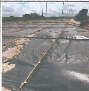
PISO EM CONCRETO COM LONA PLASTICA
