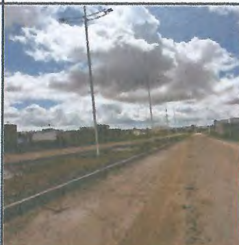
MOVIMENTAÇÃO DE TERRA, ATERRO E MEIO FIO
