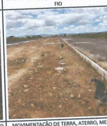
MOVIMENTAÇÃO DE TERRA, ATERRO E MEIO FIO
