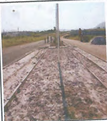
MOVIMENTAÇÃO DE TERRA, ATERRO E MEIO FIO
