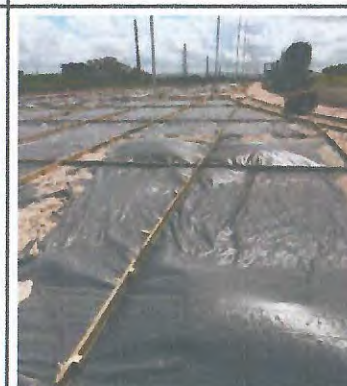
PISO EM CONCRETO COM LONA PLASTICA
