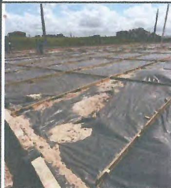
PISO EM CONCRETO COM LONA PLASTICA
