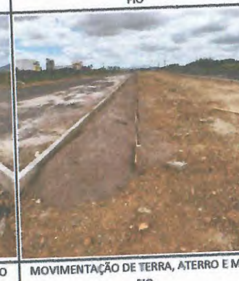
MOVIMENTAÇÃO DE TERRA, ATERRO E MEIO FIO
