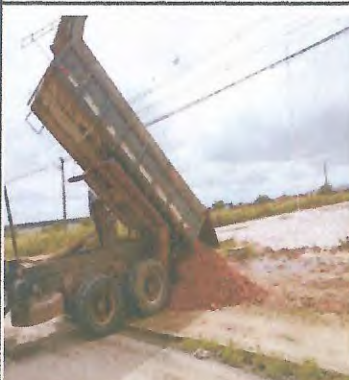
MOVIMENTAÇÃO DE TERRA E ATERRO
