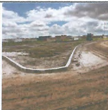
MOVIMENTAÇÃO DE TERRA, ATERRO E MEIO FIO
