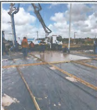
PISO EM CONCRETO COM LONA PLASTICA
