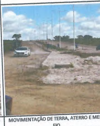
MOVIMENTAÇÃO DE TERRA, ATERRO E MEIO FIO
