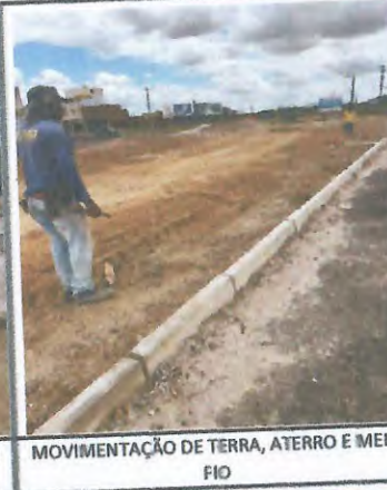
MOVIMENTAÇÃO DE TERRA, ATERRO E MEIO FIO
