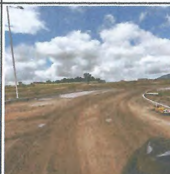
MOVIMENTAÇÃO DE TERRA, ATERRO E MEIO FIO
