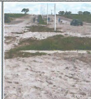
MOVIMENTAÇÃO DE TERRA, ATERRO E MEIO FIO
