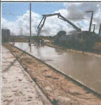
PISO EM CONCRETO COM LONA PLASTICA
