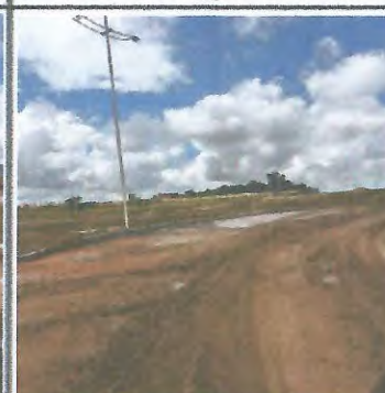
MOVIMENTAÇÃO DE TERRA, ATERRO E MEIO FIO
