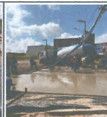
PISO EM CONCRETO COM LONA PLASTICA
