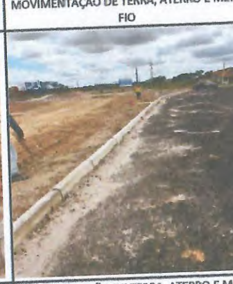
MOVIMENTAÇÃO DE TERRA, ATERRO E MEIO FIO
