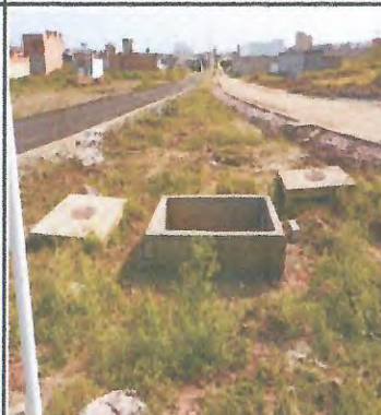
MOVIMENTAÇÃO DE TERRA E MEIO FIO
