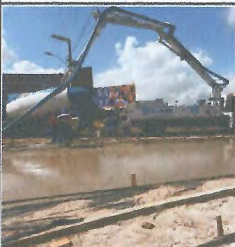
PISO EM CONCRETO COM LONA PLASTICA
