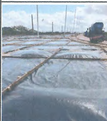
PISO EM CONCRETO COM LONA PLASTICA
