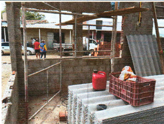
CHAPISCO INTERNO, TELHAS PARA A COBERTURA
