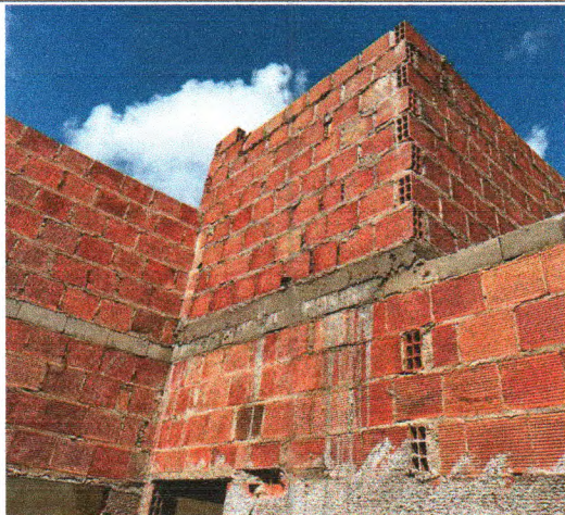
ALVENARIA E CINTAMENTO
