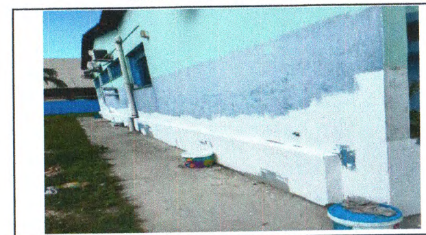
EMASSAMENTO E PINTURA DE PAREDES
