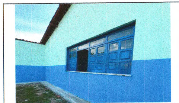
EMASSAMENTO E PINTURA DE JANELAS
