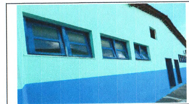
EMASSAMENTO E PINTURA DE JANELAS
