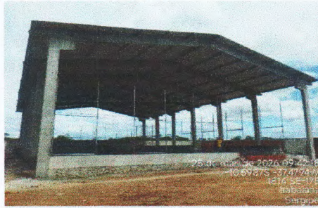
TELHAMENTO COM TELHA EM AÇO GALVALUME
