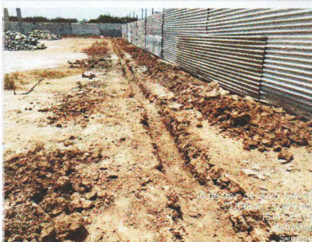
ESCAVAÇÃO MANUAL DE VALA
