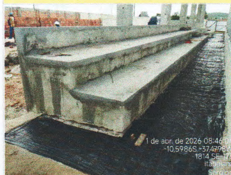
PISO EM CONCRETO SIMPLES
