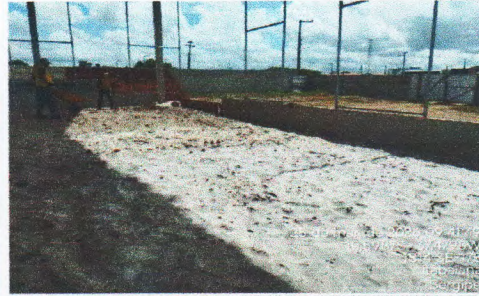
EXECUÇÃO DE ATERRO
