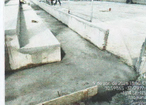
PISO EM CONCRETO SIMPLES
