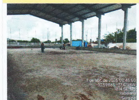
EXECUÇÃO DE ATERRO
