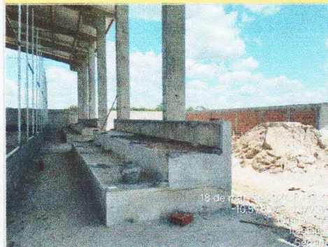
ALVENARIA DE BLOCO CERÂMICO
