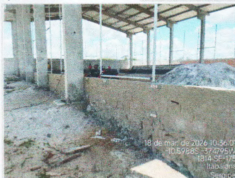
CHAPISCO E REBOCO
