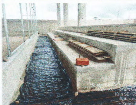
CHAPISCO E REBOCO
