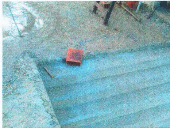
PISO DE CONCRETO;
