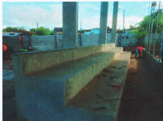
BANCO DE CONCRETO;
