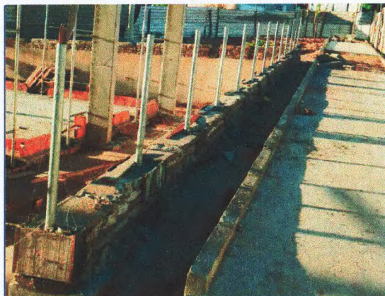
MEIO-FIO; PISO DE CONCRETO; CORRIMÃOS;
