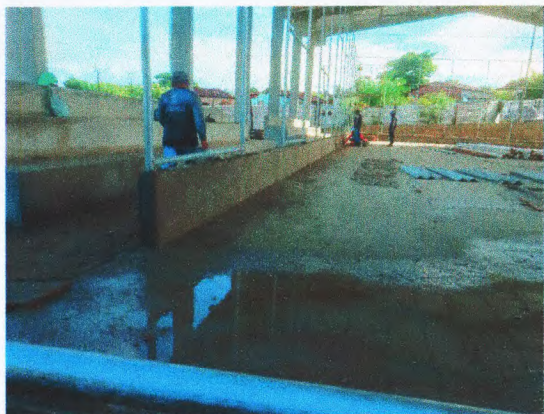
EXECUÇÃO DE PISO DE ALTA RESISTÊNCIA;
