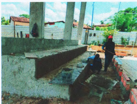
BANCO DE CONCRETO;
