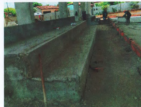
BANCO DE CONCRETO;
