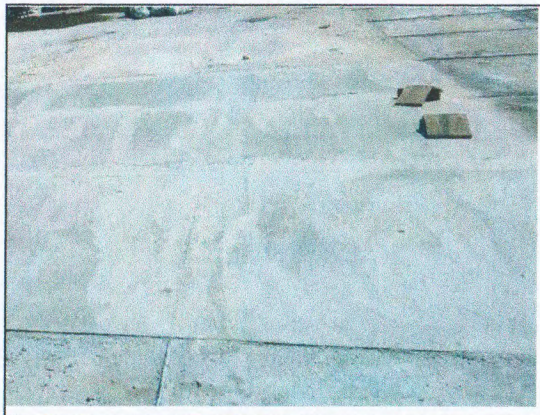
PISO DE ALTA RESISTÊNCIA - EXECUÇÃO
