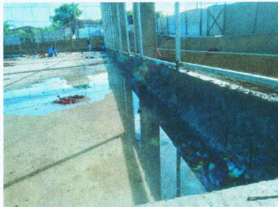
EXECUÇÃO DE PISO DE ALTA RESISTÊNCIA;
