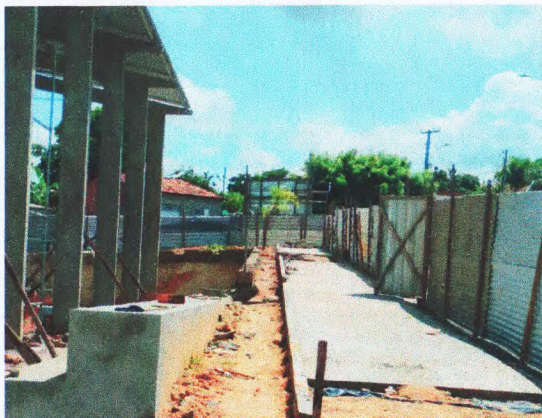
MEIO-FIO; PISO DE CONCRETO;
