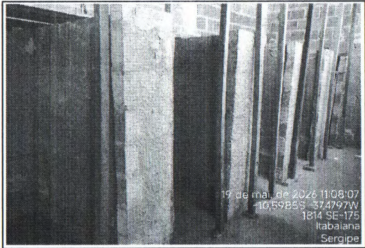
CHAPISCO EM PAREDE
