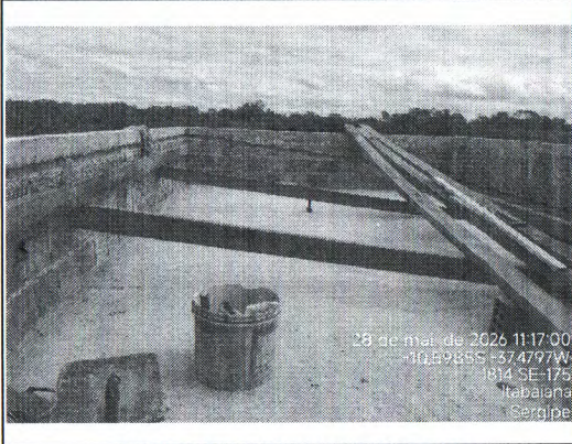
EXECUÇÃO DE TRAMA DE MADEIRA
