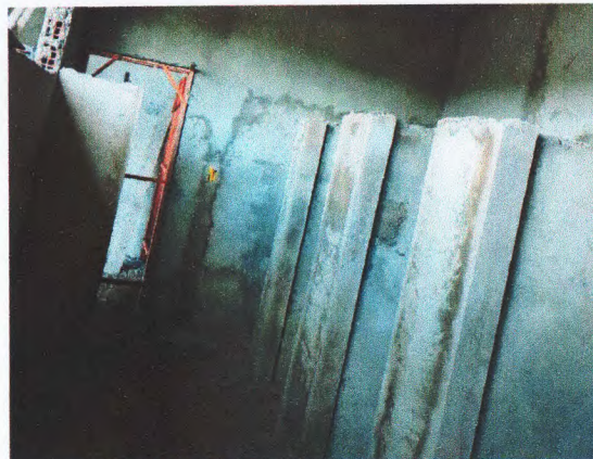
EXECUÇÃO DA REGULARIZAÇÃO DE BASE; INSTALAÇÃO DAS PORTAS;
