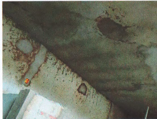
CHAPISCO E REBOCO NO TETO; INSTALAÇÕES ELÉTRICAS
