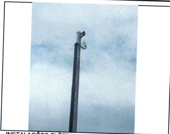
INSTALAÇÕES ELÉTRICAS - POSTE GALVANIZADO E CABOS
