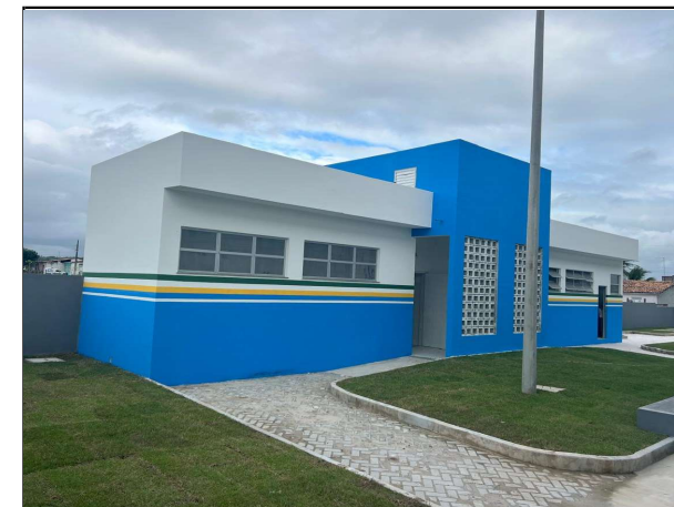
ÁREA EXTERNA, ESQUADRIAS, VIDROS, VEDAÇÕES E PINTURAS
