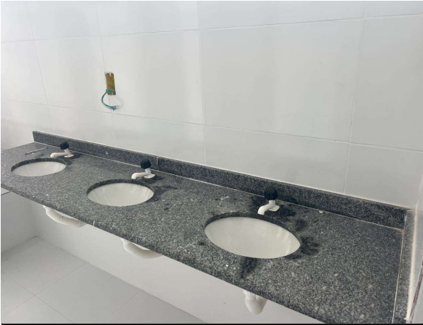
BANCADA EM GRANITO; TORNEIRAS; PONTO DE TOMADA; REVESTIMENTO CERÂMICO
