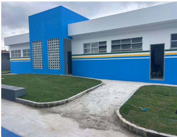
ÁREA EXTERNA, ESQUADRIAS, VIDROS, VEDAÇÕES E PINTURAS
