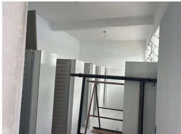
PINTURA INTERNA; ESQUADRIAS E REVESTIMENTOS CERÂMICOS
