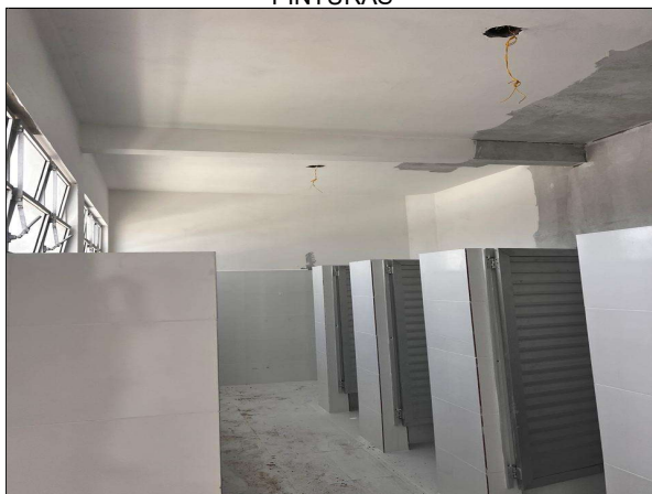
PINTURA INTERNA; ESQUADRIAS E REVESTIMENTOS CERÂMICOS
