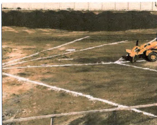
LOCAÇÃO DA REDE DE DRENAGEM;
