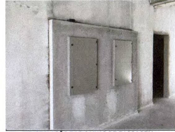
INSTALAÇÃO DAS CAIXAS DE PASSAGEM
