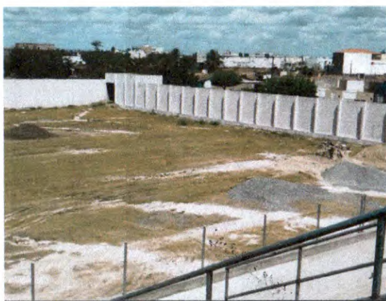
ESCAVAÇÃO MECANIZADA; PINTURA EXTERIOR;
