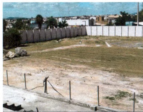
ESCAVAÇÃO MECANIZADA; PINTURA EXTERIOR;
