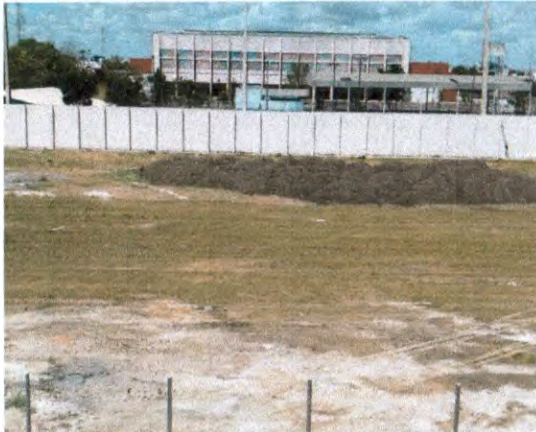
ESCAVAÇÃO MECANIZADA; PINTURA EXTERIOR;
