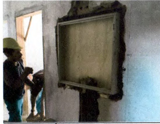
INSTALAÇÃO DAS CAIXAS DE PASSAGEM
