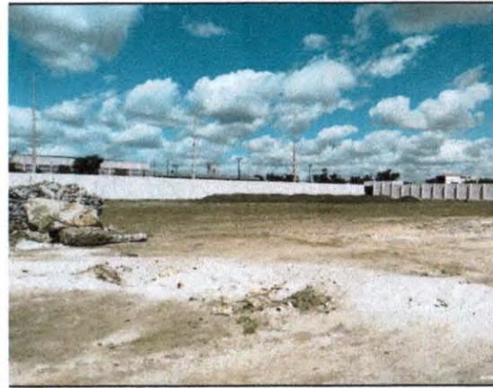
ESCAVAÇÃO MECANIZADA; PINTURA EXTERIOR;
