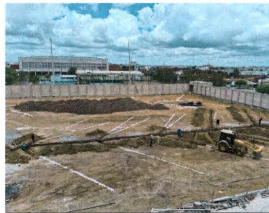
LOCAÇÃO DA REDE DE DRENAGEM;
