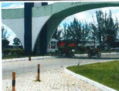
CANTEIRO DO PÓRTICO
