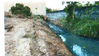
CANAL DA AVENIDA MANOEL FRANCISCO TELES
