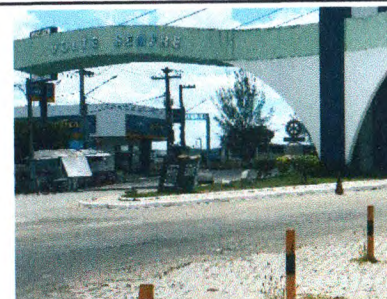
CANTEIRO DO PÓRTICO
