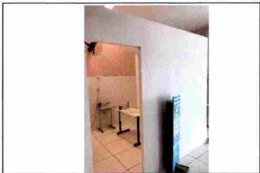
EXECUÇÃO DE PAREDE EM BLOCO DE GESSO
