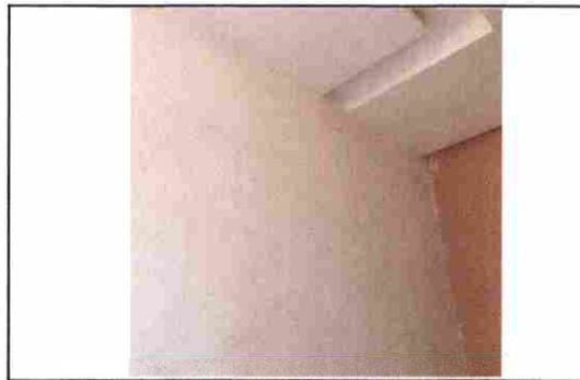
EXECUÇÃO DE PAREDE EM BLOCO DE GESSO
