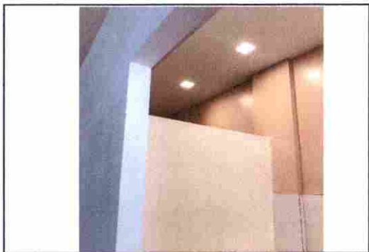
EXECUÇÃO DE PAREDE EM BLOCO DE GESSO
