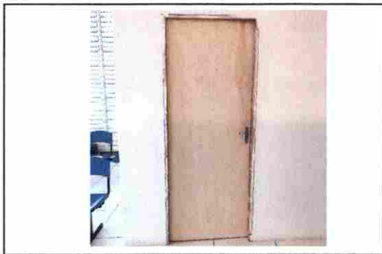
INSTALAÇÃO DE PORTA
