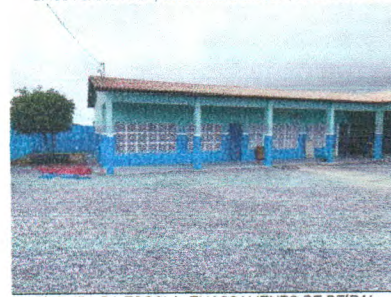
PINTURA DA ESCOLA; EMASSAMENTO DE BEIRAL; PISO CIMENTADO; MURO
