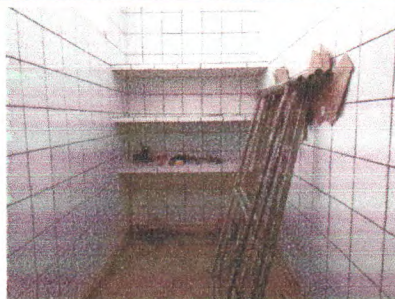
DISPENSA - REVESTIMENTO CERÂMICO PAREDE
