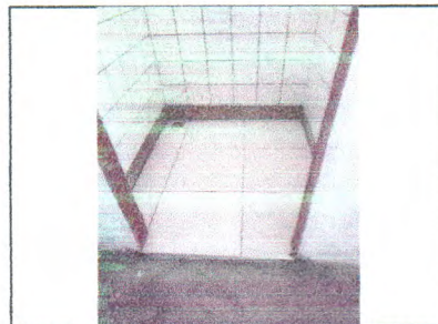
BANHEIRO - REVESTIMENTO CERÂMICO PAREDE E PISO; PONTO DE ESGOTO - RALO; CAIXÃO DA PORTA
