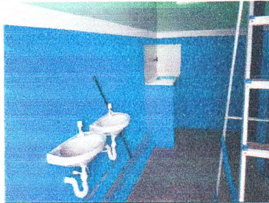
PONTOS DE ÁGUA E ESGOTO; LAVATÓRIO DE LOUÇA; PINTURA INTERNA; PISO DE ALTA RESISTÊNCIA
