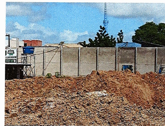
EXECUÇÃO DO MURO; MATERIAL DE REFORÇO SUB-LEITO
