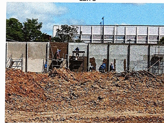
EXECUÇÃO DO MURO; MATERIAL DE REFORÇO SUB-LEITO
