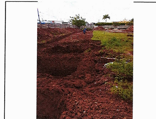
LOCAÇÃO E ESCAVAÇÃO DAS SAPATAS DO MURO
