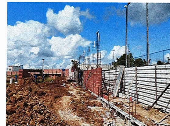
CINTAMENTO INFERIOR; FERRAGEM DOS PILARES E ALVENARIA DE BLOCO CERÂMICO
