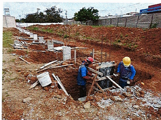
ESCAVAÇÃO; FERRAGEM E CONCRETO DAS SAPATAS
