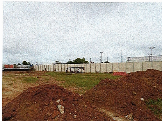
EXECUÇÃO DO MURO; MATERIAL DE REFORÇO SUB-LEITO
