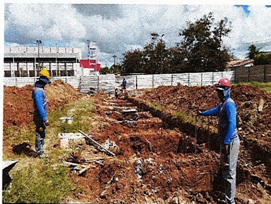
ESCAVAÇÃO; FERRAGEM E CONCRETO DAS SAPATAS
