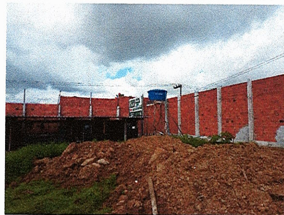
EXECUÇÃO DO MURO; MATERIAL DE REFORÇO SUB-LEITO
