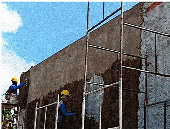
MURO - ALVENARIA DE BLOCO CERÂMICO, CHAPISCO E REBOCO
