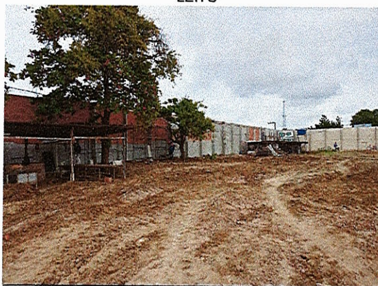
EXECUÇÃO DO MURO; MATERIAL DE REFORÇO SUB-LEITO
