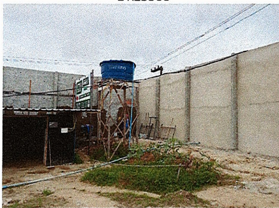
MURO - ALVENARIA DE BLOCO CERÂMICO, CHAPISCO E REBOCO
