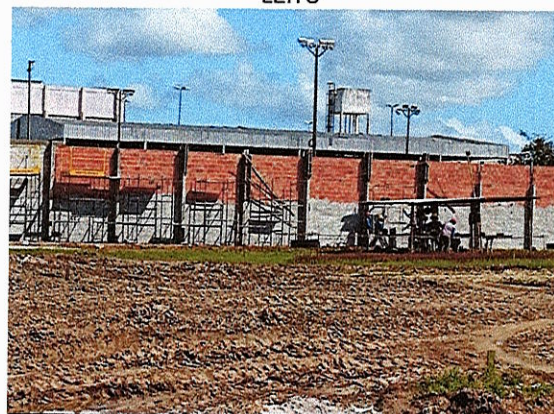
EXECUÇÃO DO MURO; MATERIAL DE REFORÇO SUB-LEITO
