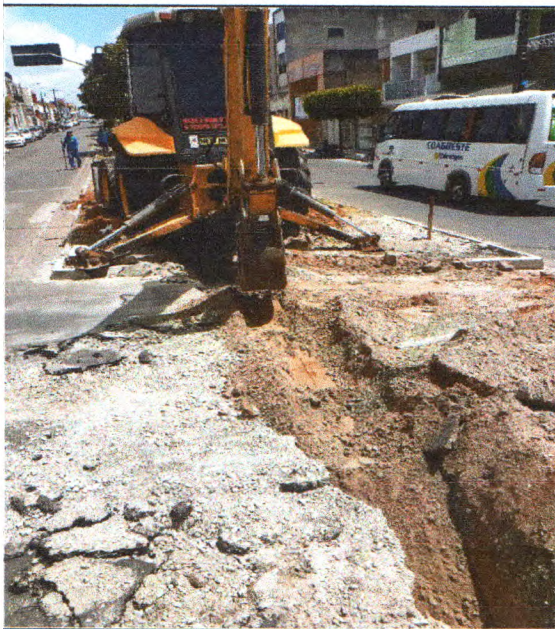
Escavação de vala com retroescavadeira
