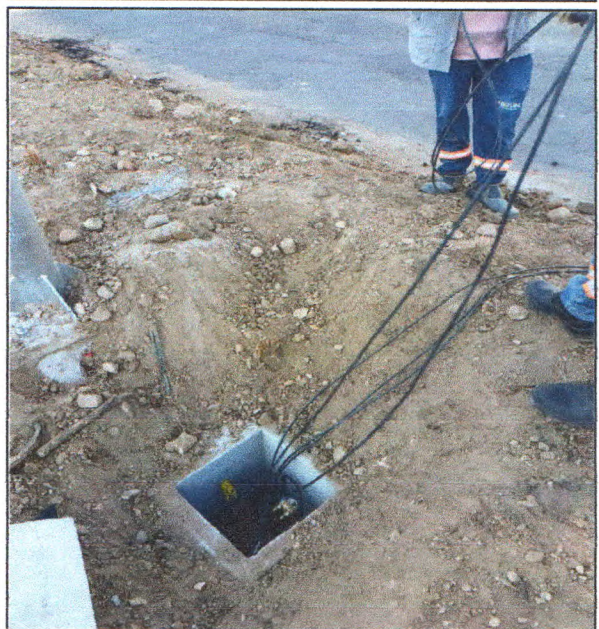
Lançamento de cabos
