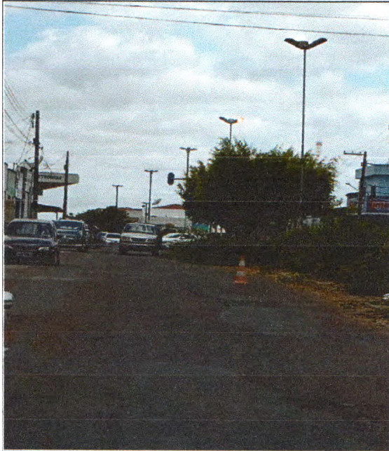
Postes galvanizados removidos
