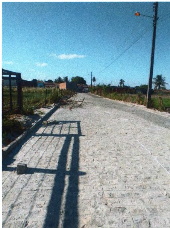
Foto 02: Pavimentação em paralelepípedo granítico sobre colchão de areia.
