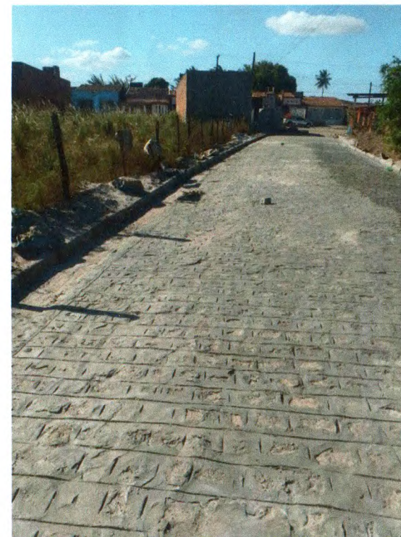
Foto 03: Conclusão da pavimentação em paralelepípedo granítico sobre colchão de areia do contratado.
