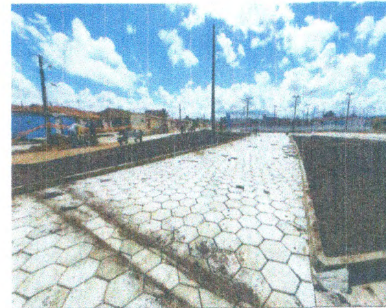
MEIO FIO; PISO INTERTRAVADO; TERRA VEGETAL
