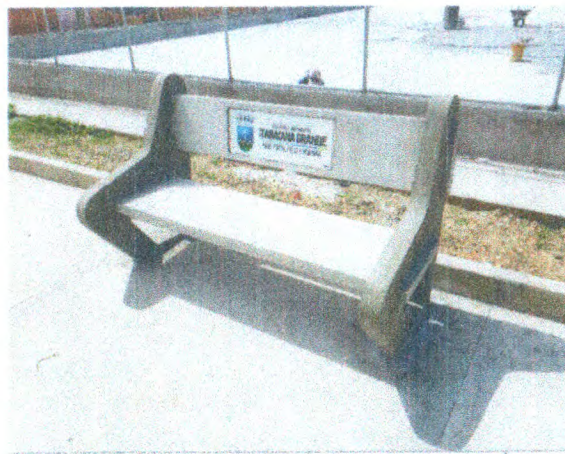
MEIO FIO; PISO EM CONCRETO; BANCO PRÉ-MOLDADO; MURETA EM ALVENARIA; ALAMBRADO
