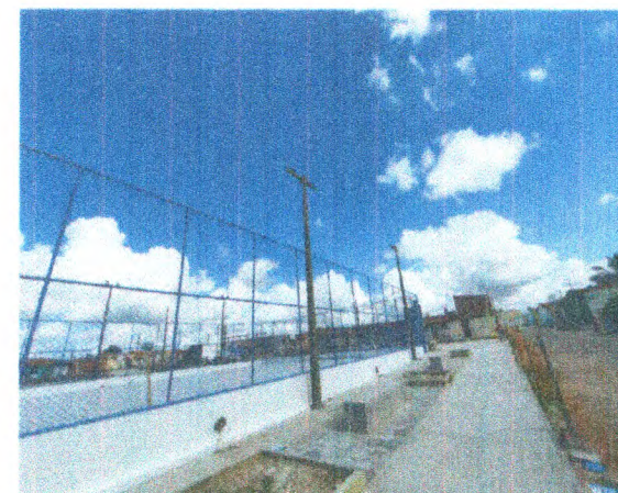
MURETA EM ALVENARIA E PINTURA; ALAMBRADO COM TELA; BANCO EM ALVENARIA; PISO INTERTRAVADO
