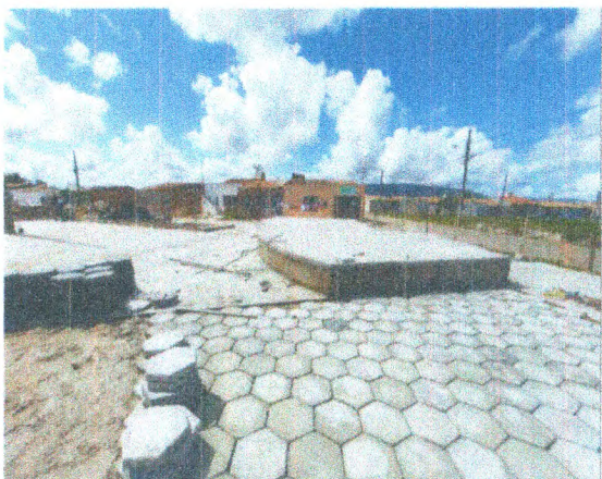
PISO EM CONCRETO; PALCO; PISO INTERTRAVADO
