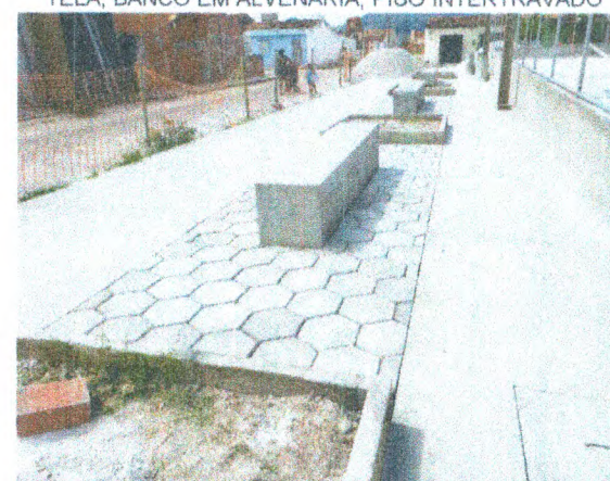
MEIO FIO; MURETA EM ALVENARIA; ALAMBRADO; BANCO EM ALVENARIA; PISO EM CONCRETO; PISO INTERTRAVADO
