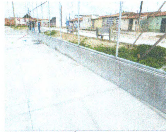
PISO EM ALTA RESISTÊNCIA; MURETA EM ALVENARIA; ALAMBRADO
