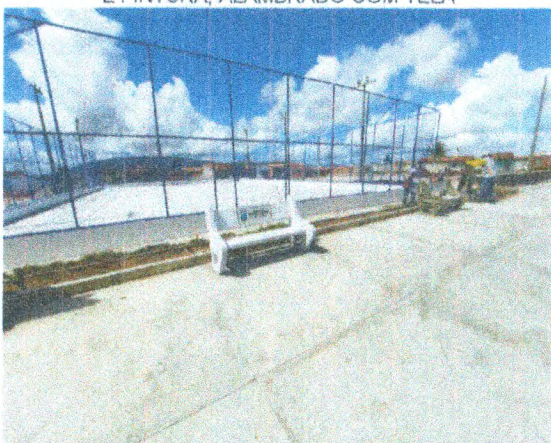
MURETA EM ALVENARIA E PINTURA; ALAMBRADO COM TELA; BANCO EM ALVENARIA; PISO EM CONCRETO
