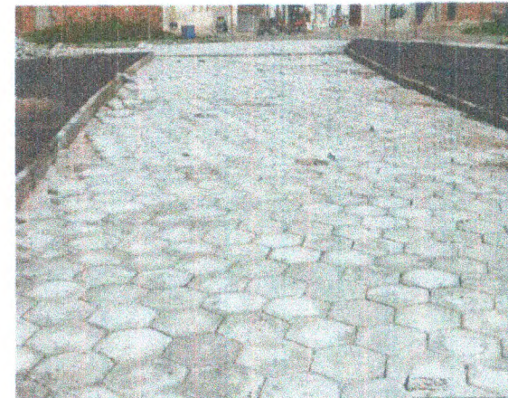
MEIO FIO; PISO INTERTRAVADO; TERRA VEGETAL
