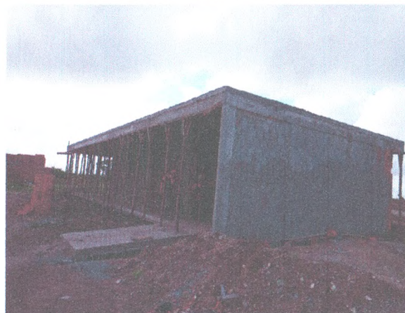
ADMINISTRAÇÃO - CINTAMENTO SUPERIOR E LAJE; CHAPISCO E REBOCO
