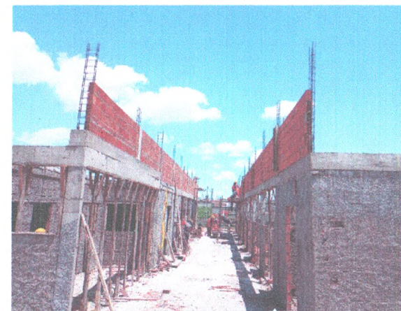
BAIAS COBERTAS - ATERRO COMPACTADO; ALVENARIA DE BLOCOS; FERRAGENS E CONCRETO
