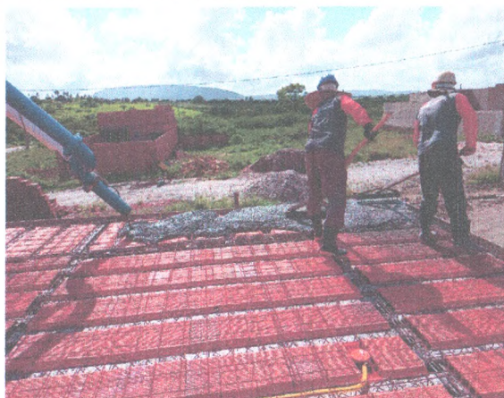
ADMINISTRAÇÃO - CONCRETAGEM DA LAJE; INSTALAÇÕES ELÉTRICA
