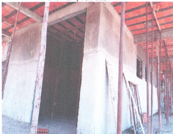
ADMINISTRAÇÃO - CINTAMENTO SUPERIOR E LAJE; CHAPISCO; REBOCO; INSTALAÇÕES ELÉTRICA
