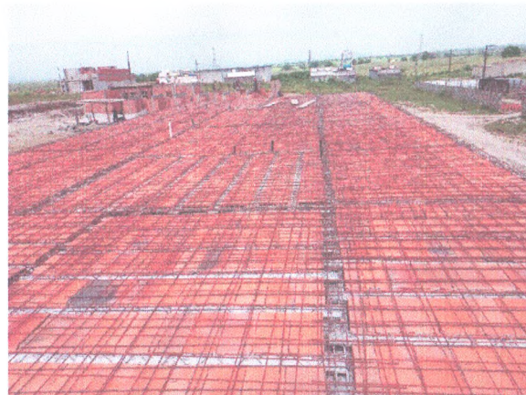
ADMINISTRAÇÃO - LAJE PRÉ-MOLDADA; FERRAGEM NEGATIVA
