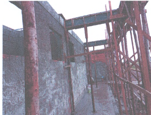
GUARITA - LAJE PRÉ-MOLDADA; CHAPISCO E REBOCO
