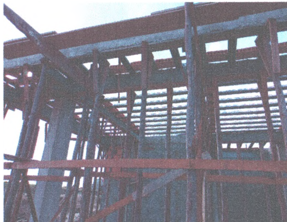
ADMINISTRAÇÃO - CINTAMENTO SUPERIOR; LAJE PRÉ-MOLDADA; ESCORAMENTO EM MADEIRA; CHAPISCO
