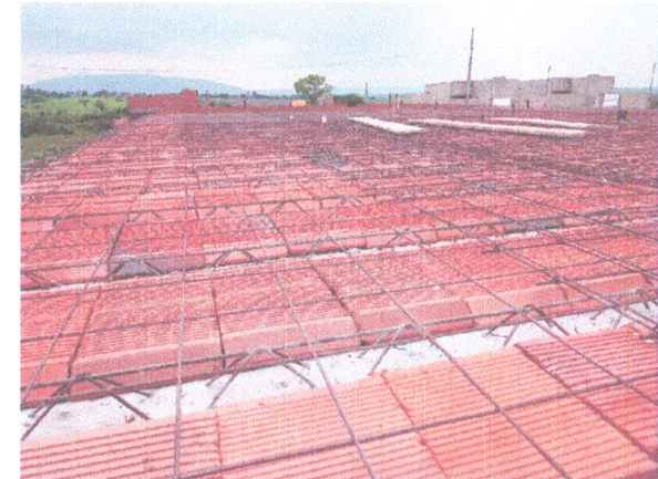
ADMINISTRAÇÃO - LAJE PRÉ-MOLDADA; FERRAGEM NEGATIVA
