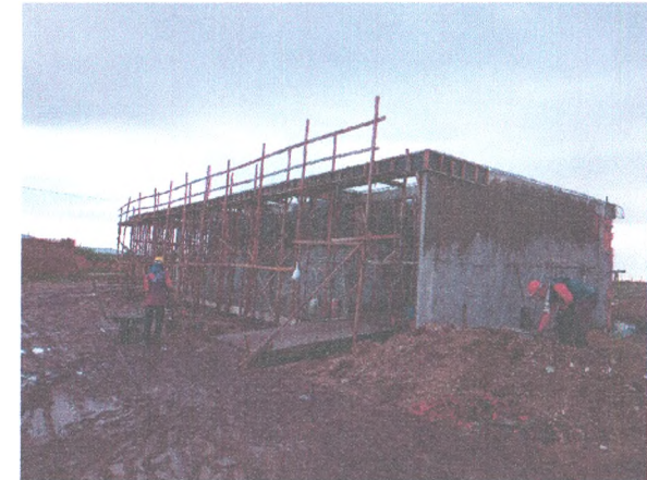
GUARITA - REBOCO/EMBOÇO; PONTOS DE ÁGUA E ESGOTO
