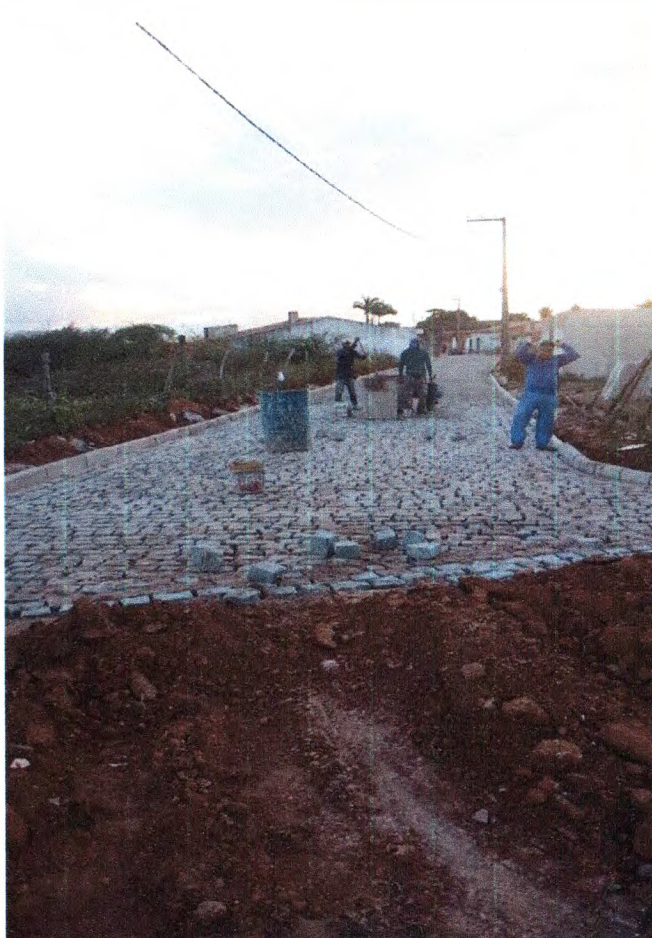
Pavimentação Travessa Tanque Vermelho 01
