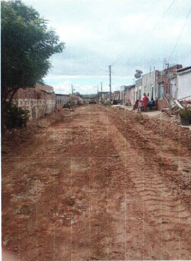
Regularização da Rua Antônio Menezes
