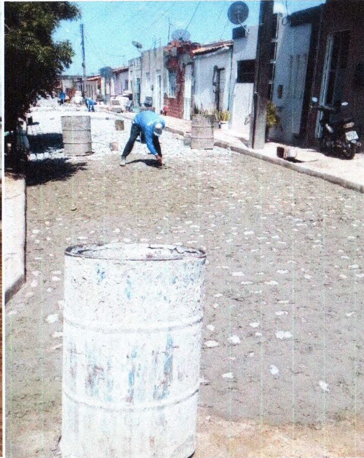
Pavimentação da Rua Antônio Menezes
