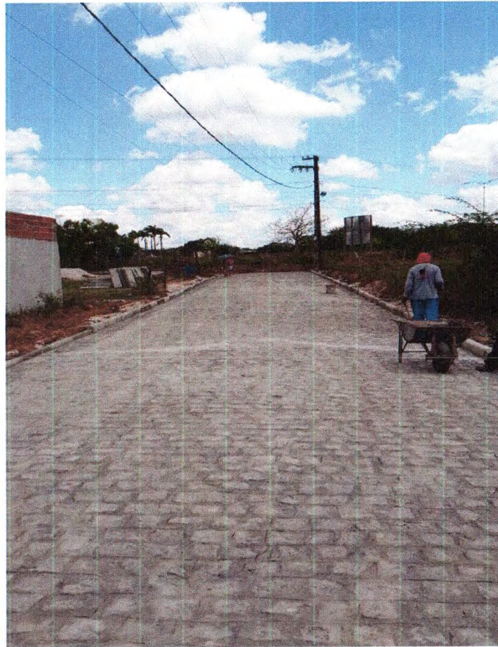
Pavimentação Travessa Tanque Vermelho 01
