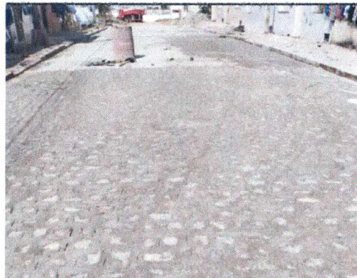
EXECUÇÃO DA PAVIMENTAÇÃO E MEIO-FIO NA RUA JOSÉ BRAZ DOS SANTOS
