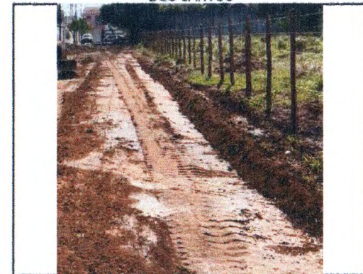
MURO DEMOLIDO; REGULARIZAÇÃO EM TRECHO DA RUA PEDRO BARBOSA DE JESUS
