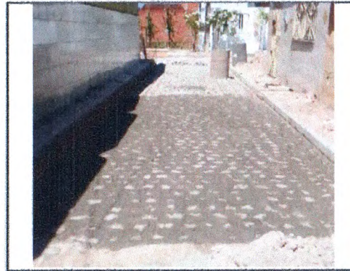
EXECUÇÃO DA PAVIMENTAÇÃO E MEIO-FIO NA RUA EGILDO SANTOS
