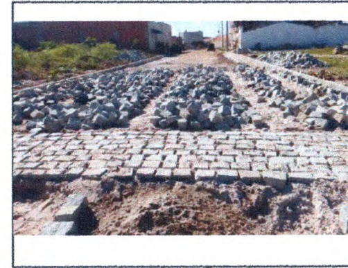
EXECUÇÃO DA PAVIMENTAÇÃO E MEIO-FIO NA RUA PROJETADA
