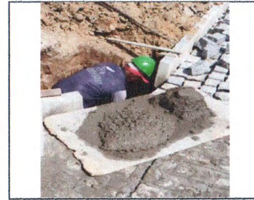
MONTAGEM DE BOCA DE LOBO NA RUA PEDRO BARBOSA DE JESUS
