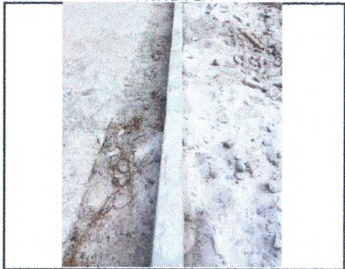
ESCORAMENTO DE MEIO-FIO DA RUA ARGENTINA
