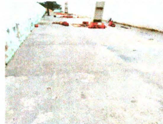
PISO DE CONCRETO
