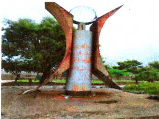
REMOÇÃO DE FERRUGEM
