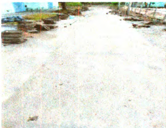
PISO EM CONCRETO
