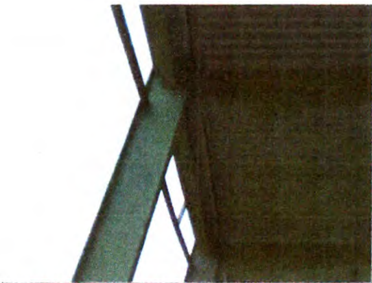
REMOÇÃO DE FERRUGEM E PINTURA PILARES METÁLICOS DA QUADRA COBERTA
