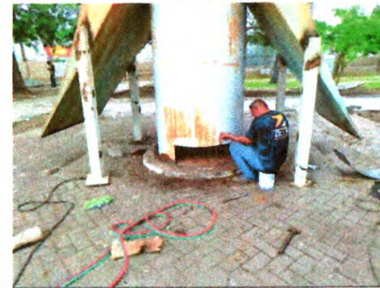
REMOÇÃO DE FERRUGEM
