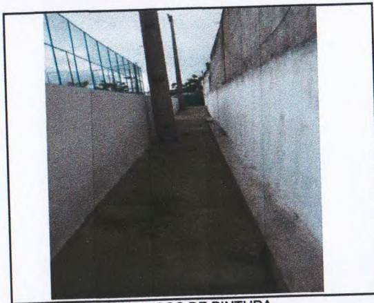
SERVIÇOS DE PINTURA.
