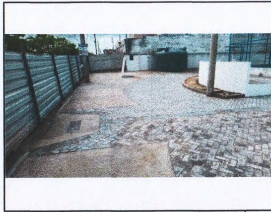
EXECUÇÃO DE PISO INTERTRAVADO E PISO TÁTIL.
