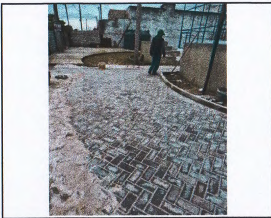
EXECUÇÃO DE PISO INTERTRAVADO.
