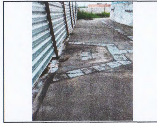
EXECUÇÃO DE RAMPA EM ACESSIBILIDADE.
