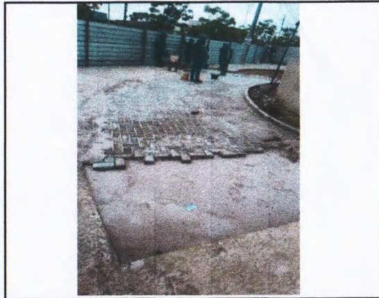
EXECUÇÃO DE PISO INTERTRAVADO.
