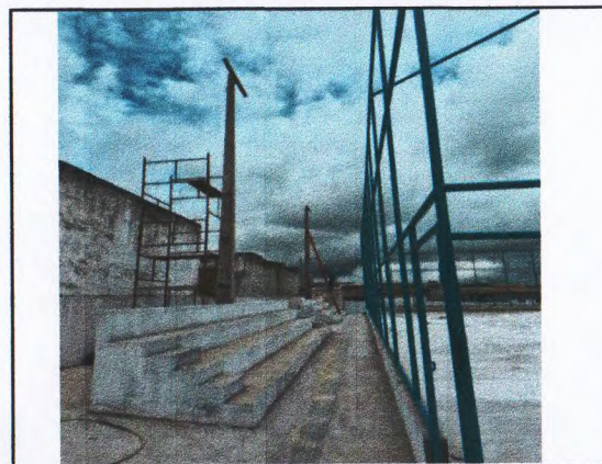
SERVIÇOS DE PINTURA EM ALAMBRADO E ARQUIBANCADA.
