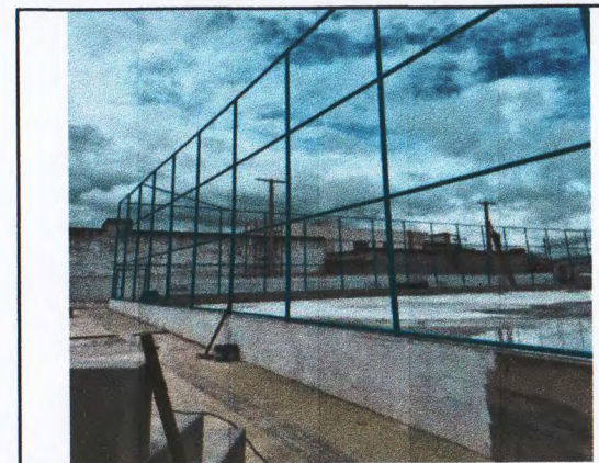
SERVIÇOS DE PINTURA EM MURETA.
