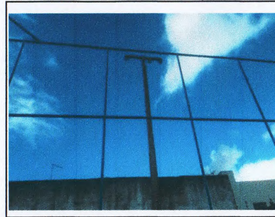
INSTALAÇÃO DE REFLETOR EM QUADRA.
