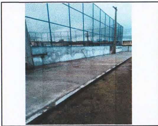
EXECUÇÃO DE PISO EM CONCRETO.
