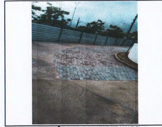
EXECUÇÃO DE PISO INTERTRAVADO.
