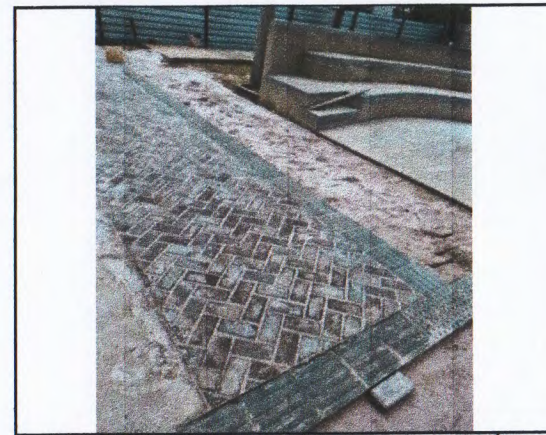
EXECUÇÃO DE PISO INTERTRAVADO E PISO TÁTIL.
