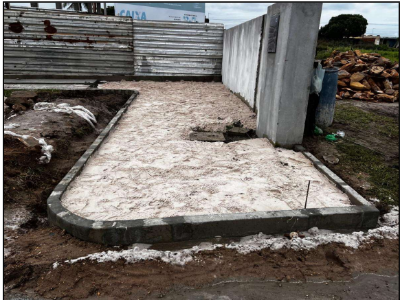
ASSENTAMENTO DE MEIO-FIO EM CONCRETO; ATERRO COMPACTADO
