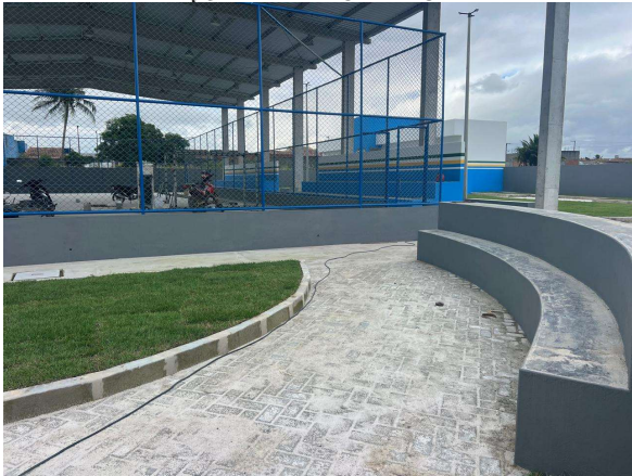
ASSENTAMENTO DE MEIO-FIO EM CONCRETO E PISO INTERTRAVADO; GRAMA ESMERALDA; PINTURA DE BANCOS, ARQUIBANCADA E MURETA
