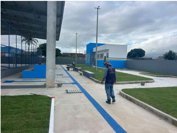
PINTURA DE MEIO-FIO; PISO EM CONCRETO; GRAMA ESMERALDA; PINTURA DE BANCOS, MURO E MURETA
