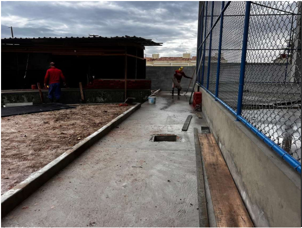
MEIO-FIO EM CONCRETO; PISO EM CONCRETO; DRENAGEM PLUVIAL - CAIXAS DE PASSAGEM
