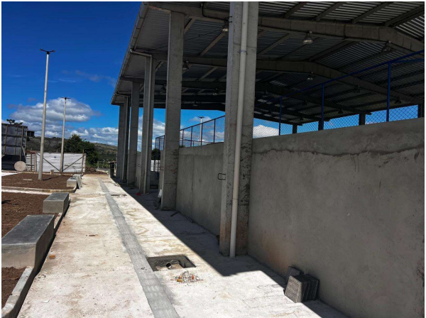
PISO TÁTIL DIRECIONAL; BANCOS; DRENAGEM PLUVIAL - CAIXAS DE PASSAGEM E TUBOS DE PVC
