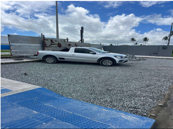
LASTRO DE BRITA; RAMPA DE ACESSO PARA DEFICIENTE; PINTURA DE MURO
