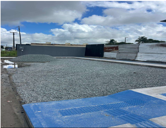
LASTRO DE BRITA; RAMPA DE ACESSO PARA DEFICIENTE
