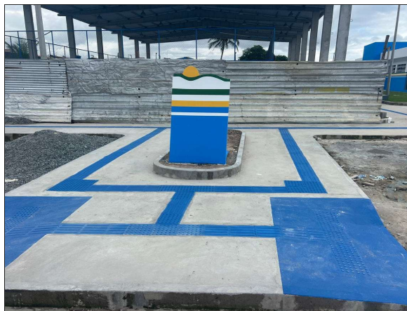
MARCO INAUGURAL; RAMPAS DE ACESSIBILIDADE; PISO TÁTIL DIRECIONAL; PISO EM CONCRETO
