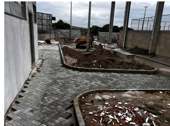
ASSENTAMENTO DE MEIO-FIO EM CONCRETO E PISO INTERTRAVADO
