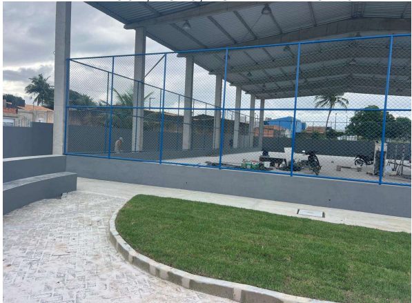
ASSENTAMENTO DE MEIO-FIO EM CONCRETO E PISO INTERTRAVADO; GRAMA ESMERALDA; PINTURA DE BANCOS, MURO E MURETA
