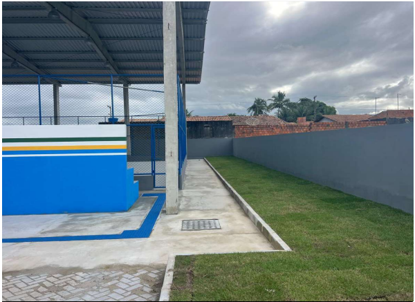
MEIO-FIO EM CONCRETO; PISO EM CONCRETO; DRENAGEM PLUVIAL - CAIXA DE PASSAGEM; GRAMA ESMERALDA; PINTURA MURO E ARQUIBANCADA
