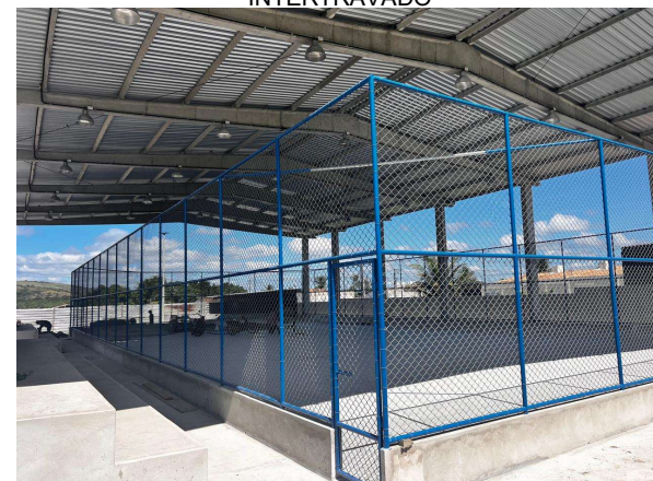
PISO DE ALTA RESISTÊNCIA; ALAMBRADO; INSTALAÇÕES ELÉTRICAS - LUMINÁRIAS INDUSTRIAIS, ELETRODUTOS E CABOS
