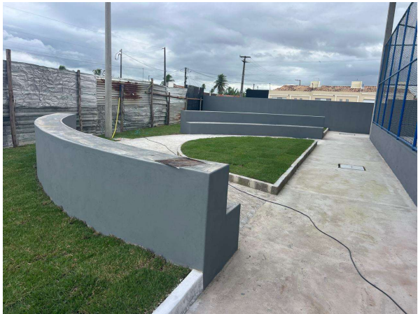
PISO EM CONCRETO; GRAMA ESMERALDA; PINTURA DE BANCOS, MURO; MURETA E MEIO-FIO
