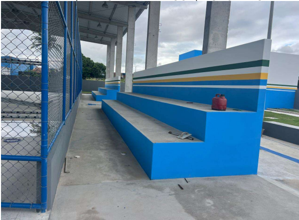
PISO EM CONCRETO; PINTURA DA ARQUIBANCADA E MURETA; ALAMBRADO; INSTALAÇÕES ELÉTRICAS - LUMINÁRIAS
