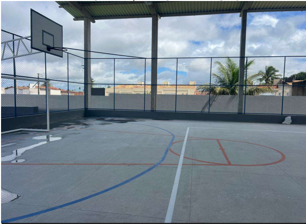
EQUIPAMENTOS DE ESPORTE - TRAVE DE FUTSAL E TABELA DE BASQUETE; PISO EM ALTA RESISTÊNCIA; DEMARCAÇÃO DA QUADRA
