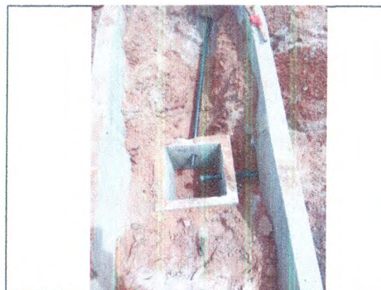
MEIO-FIO EM CONCRETO; CAIXA DE PASSAGEM; ELETRODUTO DE PVC
