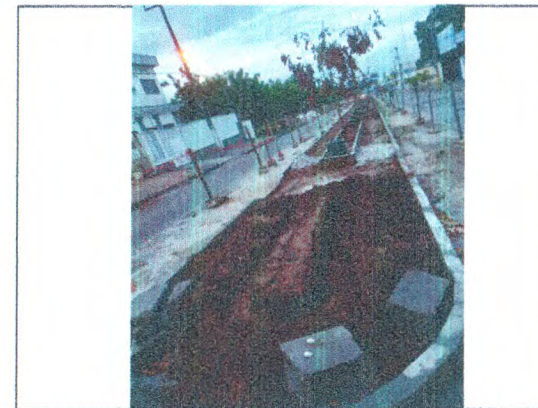
TAPUME DE PROTEÇÃO EM TELA; ASSENTAMENTO DE MEIO-FIO EM CONCRETO; ESCAVAÇÃO
