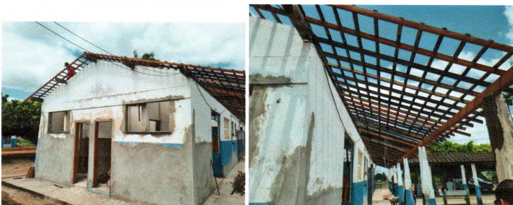
Fotos 12. Execução de novo madeiramento, assentamento de vigas de portas, instalação de novos caixões, assentamento de peitoris, execução de reboco
