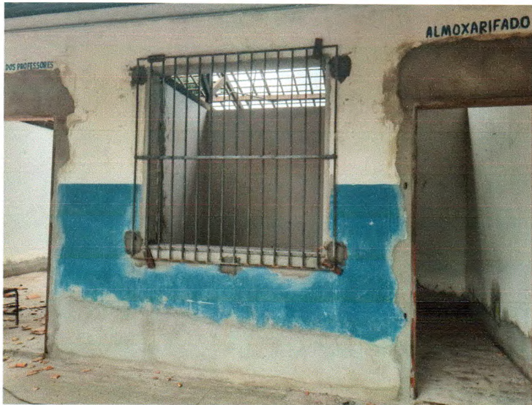
Fotos 14. Instalação de gradil novo
