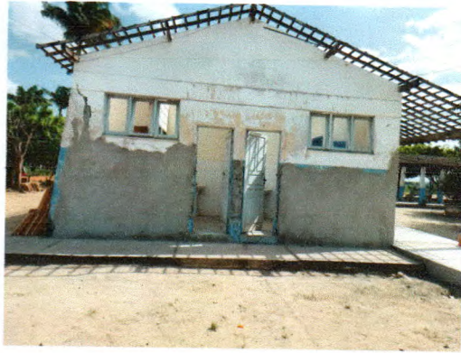
Fotos 07. Remoção de esquadrias de madeira, gradis e telhas para lavagem e substituição do madeiramento
