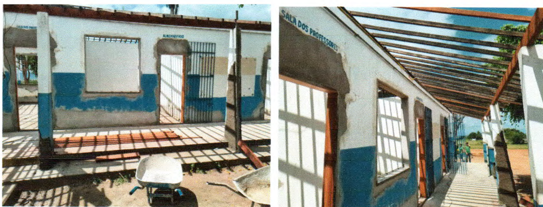
Fotos 11. Execução de novo madeiramento, assentamento de vigas de portas, instalação de novos caixões, assentamento de peitoris, execução de reboco
