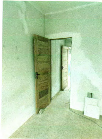
Fotos 26. Instalação de novas portas e acessórios, execução de forro de gesso e emassamento de paredes
