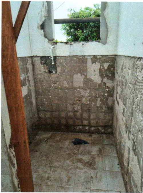
Fotos 09. Remoção do revestimento dos banheiros
