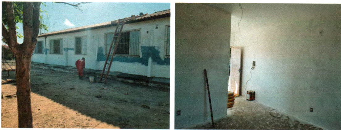
Fotos 20. Emassamento de paredes, execução de forro de gesso, instalação de novas tomadas e interruptores
