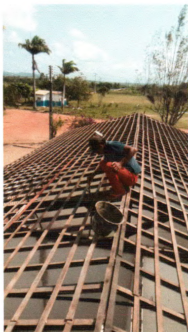
Fotos 18. Aplicação do imunizante no madeiramento
