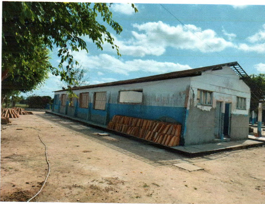
Fotos 08. Remoção de telhas para limpeza de todo o bloco
