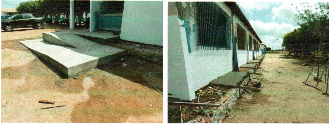
Fotos 24. Execução de rampa de acesso ao Bloco da Administração e execução do passeio
