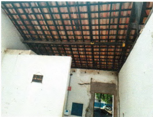
Fotos 15. Retelhamento e início da execução de serviços elétricos
