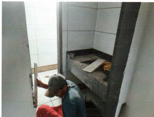
Fotos 02. Instalação de lavatórios de granito do Bloco do Laboratório
