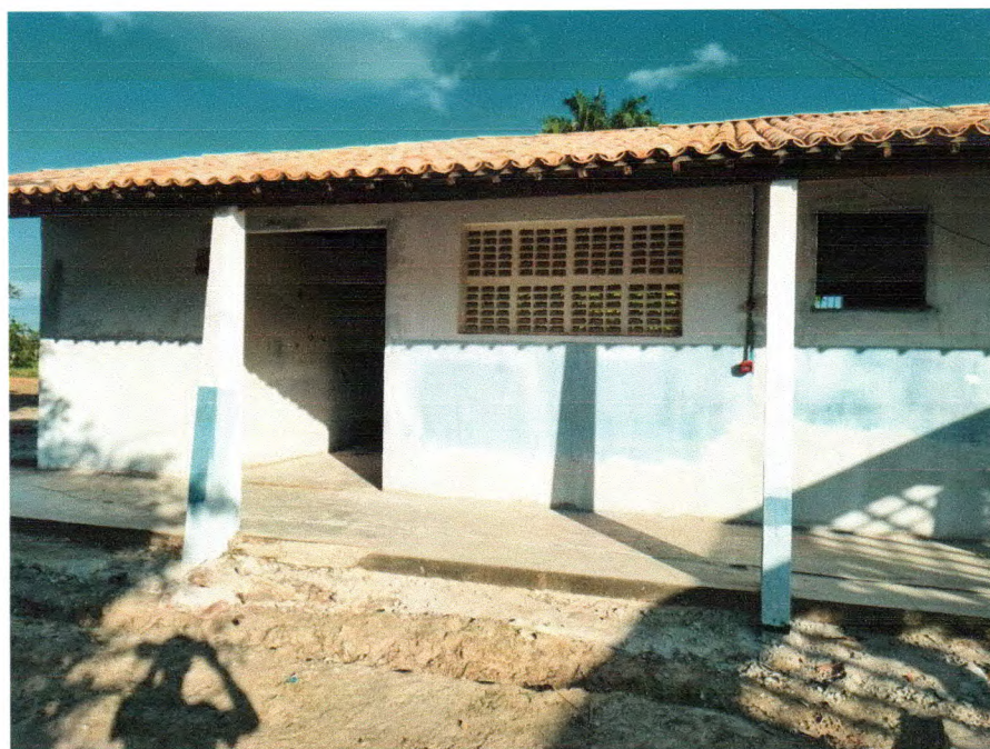
Fotos 17. Retelhamento e aplicação de selador nas paredes
