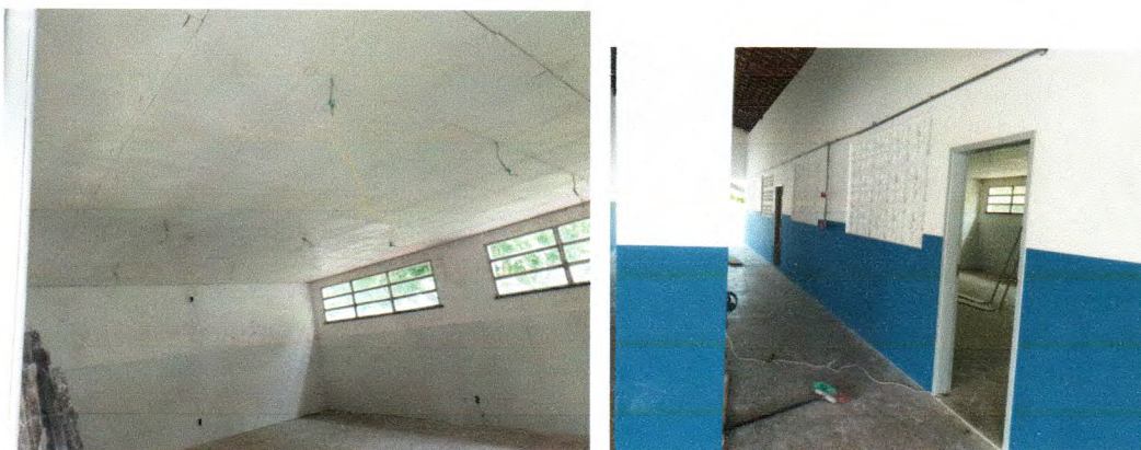
Fotos 01. Execução do revestimento interno e pintura da parte interna do Bloco das Salas de Aulas
