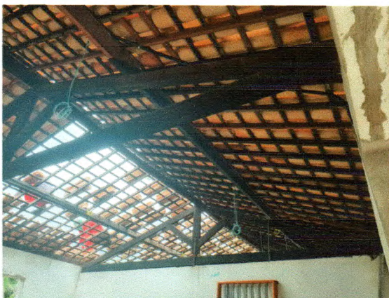
Fotos 16. Retelhamento e início da execução de serviços elétricos, aplicação de selador nas paredes
