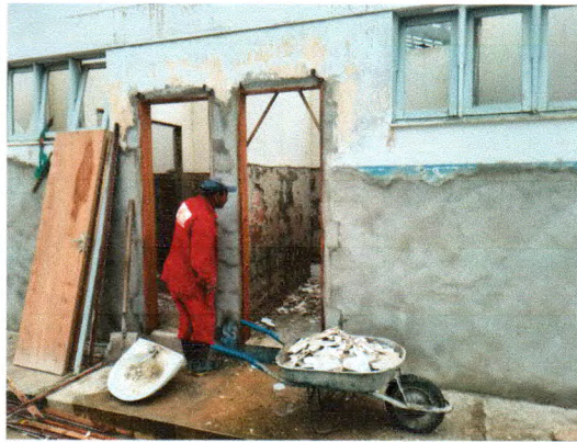
Fotos 09. Remoção do revestimento dos banheiros
