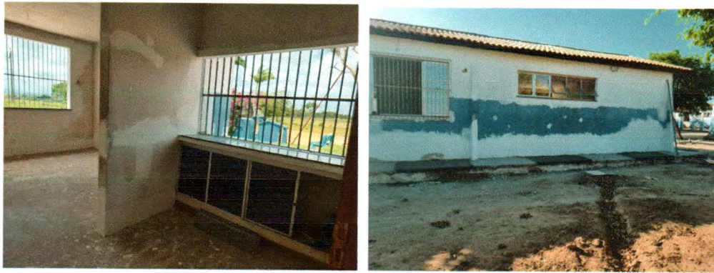
Fotos 19. Emassamento de paredes, instalação de esquadrias, instalação de peitoris
