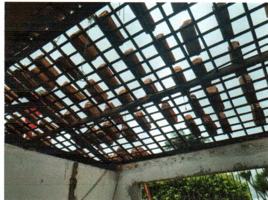
Fotos 15. Retelhamento e início da execução de serviços elétricos
