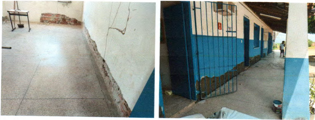
Fotos 04. Demolição de reboco e execução de novo chapisco e reboco do Bloco da Administração
