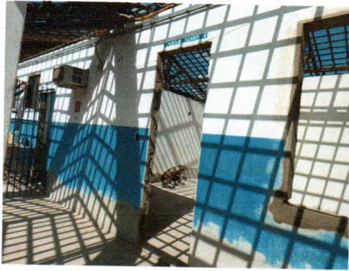
Fotos 07. Remoção de esquadrias de madeira, gradis e telhas para lavagem e substituição do madeiramento
