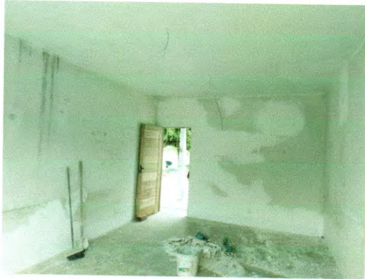
Fotos 26. Instalação de novas portas e acessórios, execução de forro de gesso e emassamento de paredes
