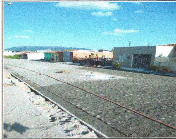
PAVIMENTAÇÃO NA RUA ANTÔNIO DOS REIS
