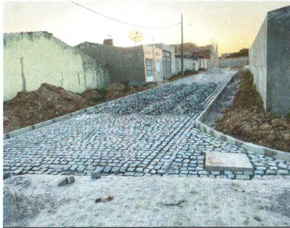
COLCHÃO DE AREIA, MEIO FIO E PARALELEPIPEDO NA TRAV PROJETADA 02
