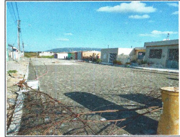
PAVIMENTAÇÃO NA RUA ANTÔNIO DOS REIS
