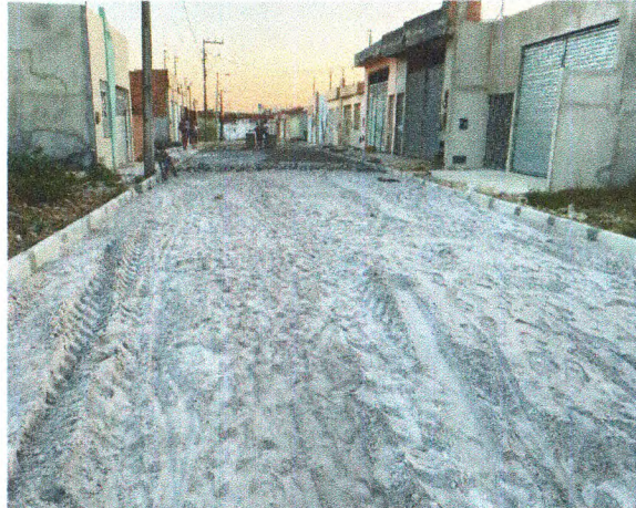
COLCHÃO DE AREIA, MEIO FIO E PARALELEPIPEDO NA RUA ANTÔNIO OLIVEIRA
