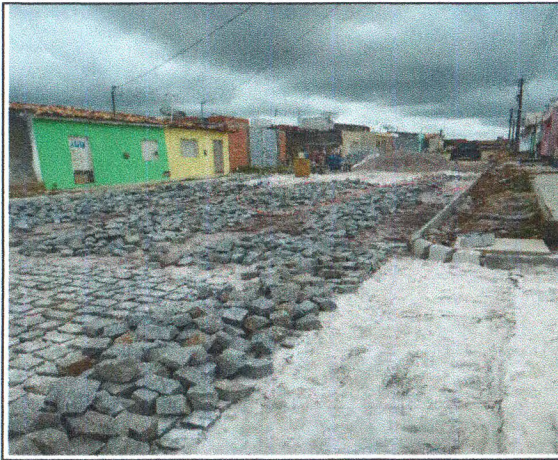
COLCHÃO DE AREIA, MEIO FIO E PARALELEPIPEDO NA RUA ANTÔNIO DOS REIS
