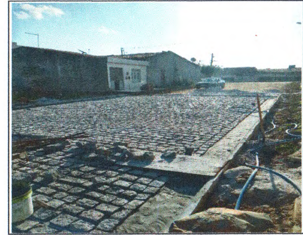
COLCHÃO DE AREIA, MEIO FIO E PARALELEPIPEDO NA RUA ANTÔNIO DOS REIS
