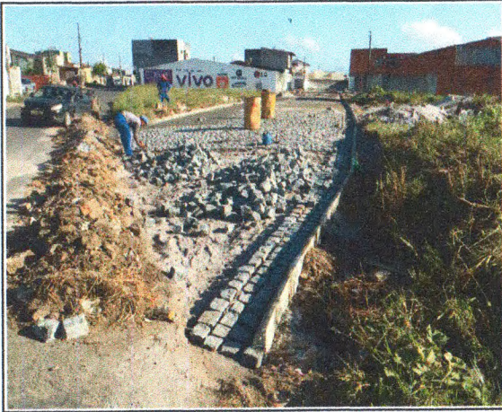
COLCHÃO DE AREIA, MEIO FIO E PARALELEPÍPEDO NA TRV. CRISLAINE DOS SANTOS
