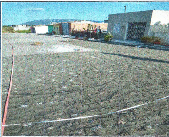
PAVIMENTAÇÃO NA RUA ANTÔNIO DOS REIS
