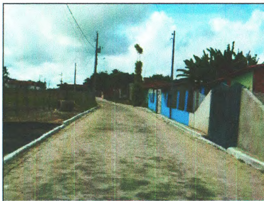
LIMPEZA E PINTURA DE CAIAÇÃO
