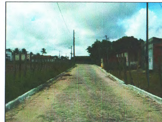
LIMPEZA E PINTURA DE CAIAÇÃO
