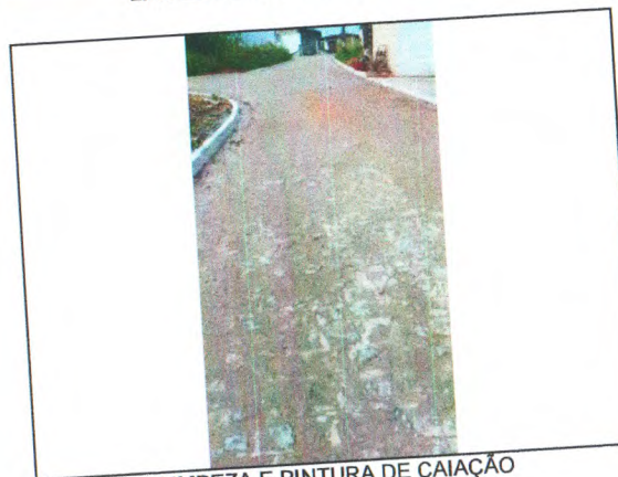
LIMPEZA E PINTURA DE CAIAÇÃO
