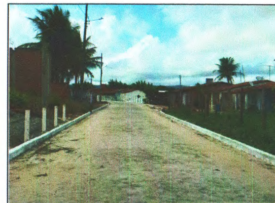
LIMPEZA E PINTURA DE CAIAÇÃO
