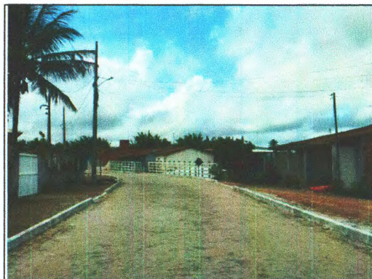
LIMPEZA E PINTURA DE CAIAÇÃO
