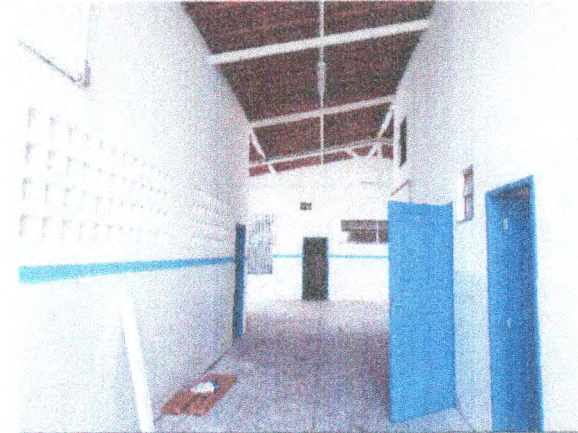
PORTA DE MADEIRA ALMOFADADA; PINTURA DE PAREDE E PORTAS; INSTALAÇÕES ELÉTRICAS; POLIMENTO DO PISO EM ALTA RESISTÊNCIA
