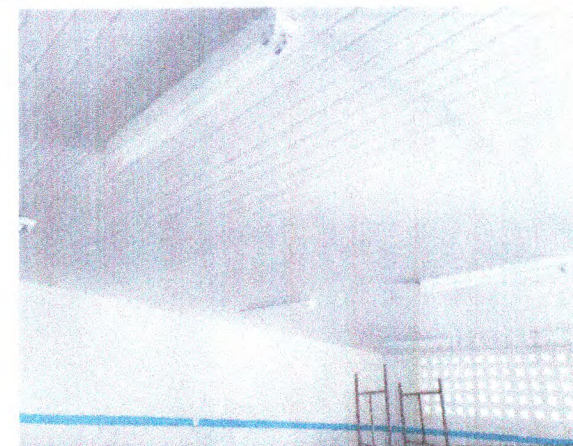
PINTURA DE PAREDE; FORRO DE PVC; INSTALAÇÕES ELÉTRICAS
