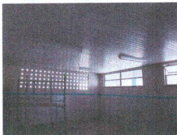
PINTURA DE PAREDE; FORRO DE PVC; INSTALAÇÕES ELÉTRICAS; REVISÃO DE ESQUADRIA DE ALUMÍNIO; VIDROS; POLIMENTO DO PISO EM ALTA RESISTÊNCIA
