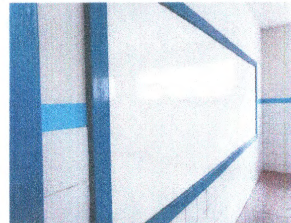
PORTA DE MADEIRA ALMOFADADA; QUADRO; PINTURA DE PAREDE E PORTAS; INSTALAÇÕES ELÉTRICAS
