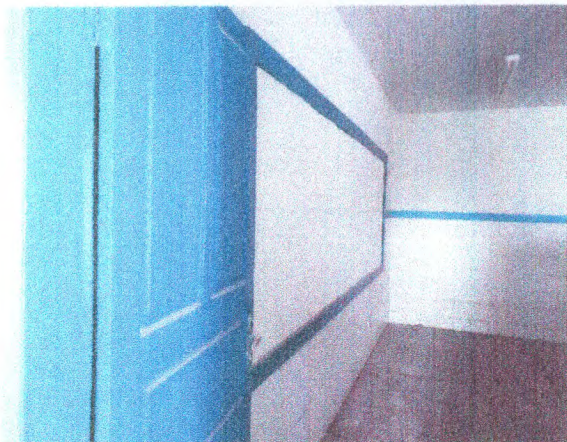
PORTA DE MADEIRA ALMOFADADA; QUADRO; PINTURA DE PAREDE E PORTAS; INSTALAÇÕES
