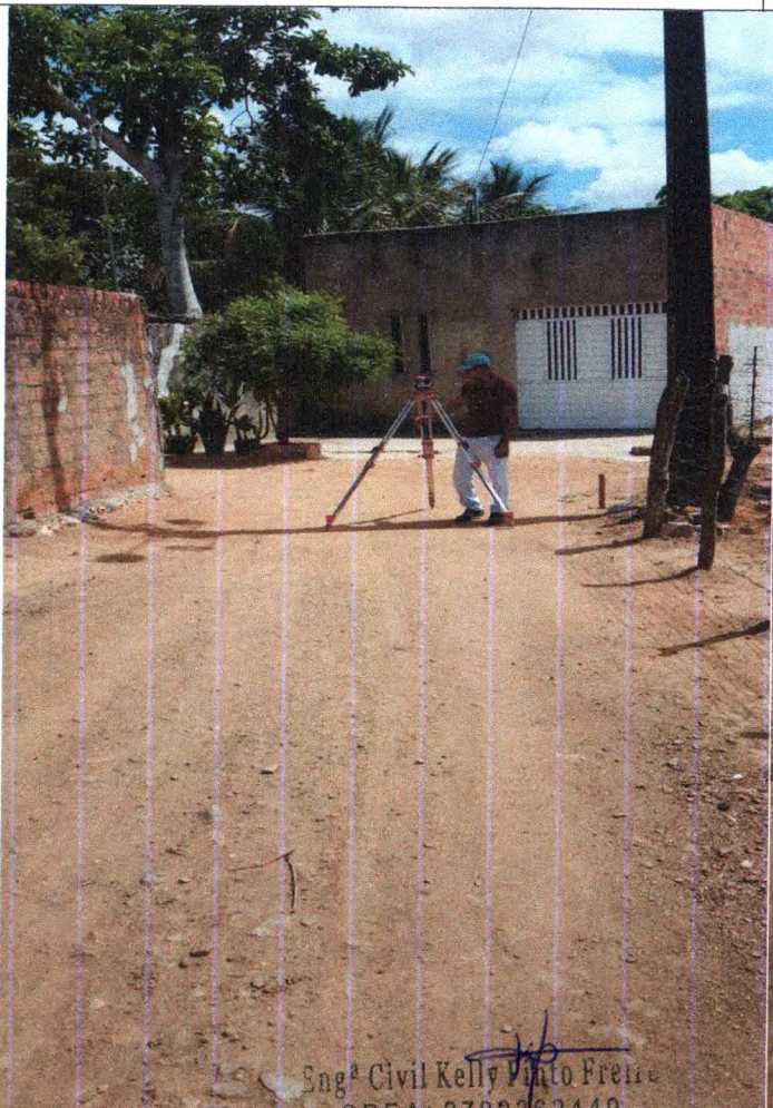
Locação da Pavimentação da Rua Projetada 02
