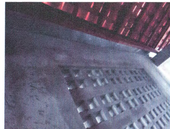
CALHA EM CHAPA DE AÇO GALVANIZADO
