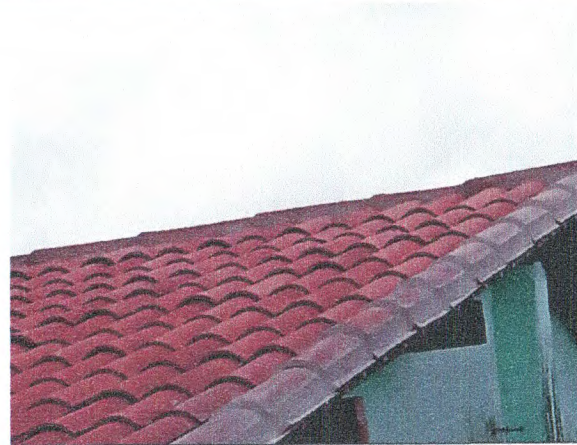
REVISÃO DA COBERTURA EM TELHA CERÂMICA; EMASSAMENTO DE BEIRAL E CUMEEIRA
