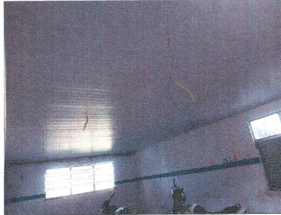
REFORMA - FORRO DE PVC; INSTALAÇÃO ELÉTRICA
