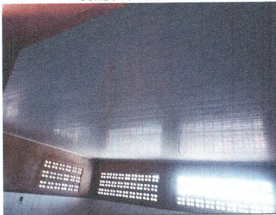
AMPLIAÇÃO - FORRO DE PVC; REVESTIMENTO CERÂMICO PAREDE; INSTALAÇÃO ELÉTRICA; COMBOGÓ DE CIMENTO
