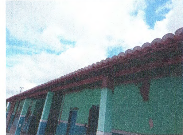
REVISÃO DA COBERTURA EM TELHA CERÂMICA; EMASSAMENTO DE BEIRAL
