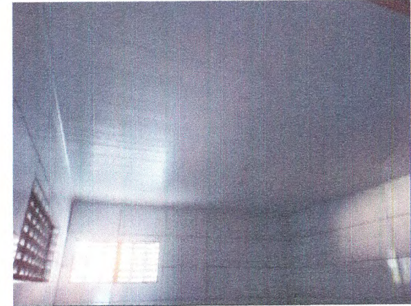
AMPLIAÇÃO - FORRO DE PVC; REVESTIMENTO CERÂMICO PAREDE; INSTALAÇÃO ELÉTRICA;
