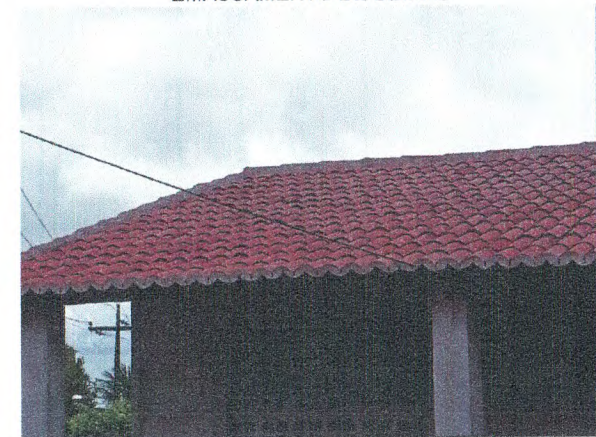
REVISÃO DA COBERTURA EM TELHA CERÂMICA; EMASSAMENTO DE BEIRAL E CUMEEIRA
