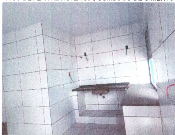
COZINHA - REVESTIMENTO CERÂMICO PAREDE E PISO; PONTOS DE ENERGIA, ÁGUA E ESGOTO
