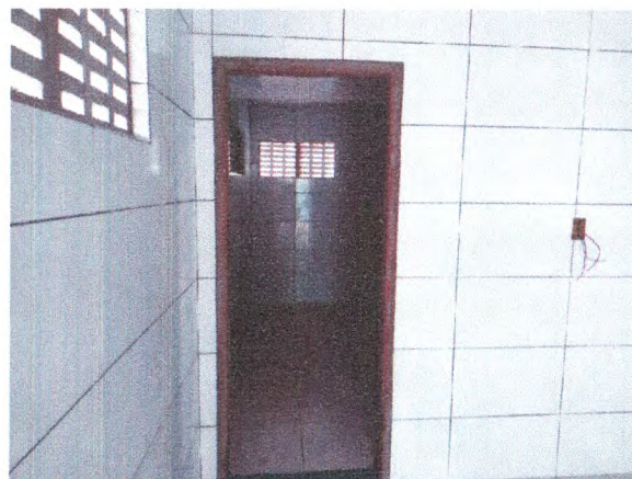
DISPENSA - REVESTIMENTO CERÂMICO PAREDE E PISO; CAIXÃO EM MADEIRA PARA PORTA; PONTO DE ENERGIA; COMBOGÓ DE CIMENTO
