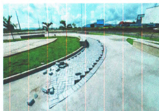
PAVIMENTAÇÃO EM BLOCO INTERTRAVADO NA ROTATÓRIA 01
