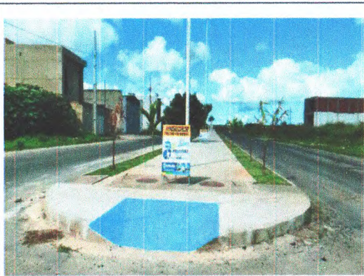
RAMPA DE DEFICIENTE DO CANTEIRO 04
