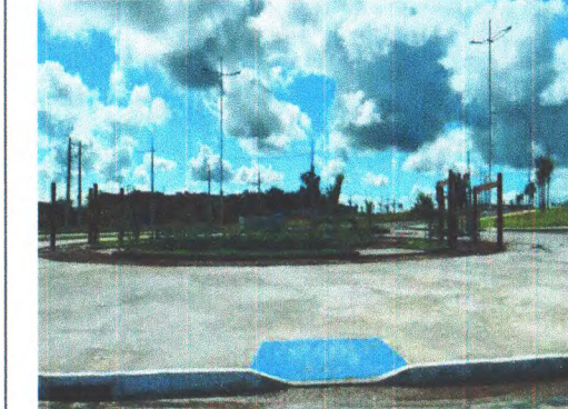
RAMPA DE DEFICIENTE NA ROTATÓRIA 03
