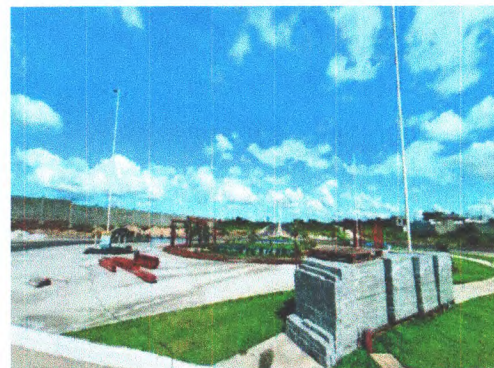
PAVIMENTAÇÃO EM BLOCO INTERTRAVADO NA ROTATÓRIA 03
