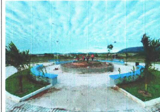
CHAPISCO E REBOCO NA ROTATÓRIA 02
