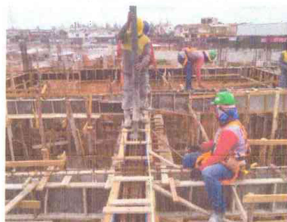
CONCRETO USINADO E BOMBEAMENTO VIGAS 1ª LAJE
