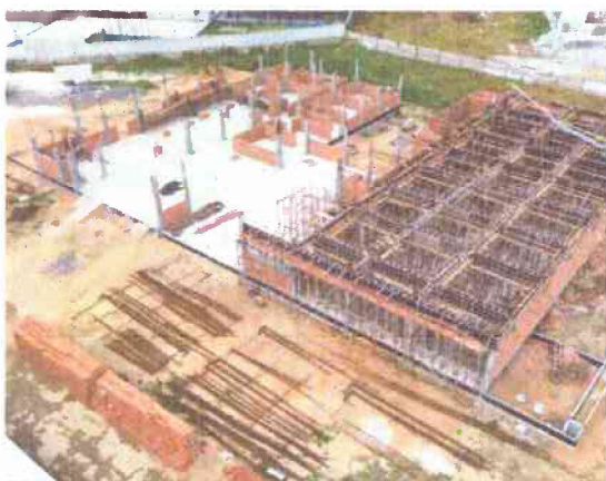
ALVENARIA DE VEDAÇÃO, FORMA E AÇO DAS VIGAS 1ª LAJE
