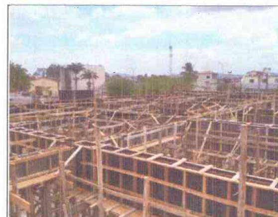
FORMA E AÇO DAS VIGAS 1ª LAJE
