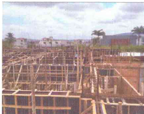
FORMA E AÇO DAS VIGAS 1ª LAJE
