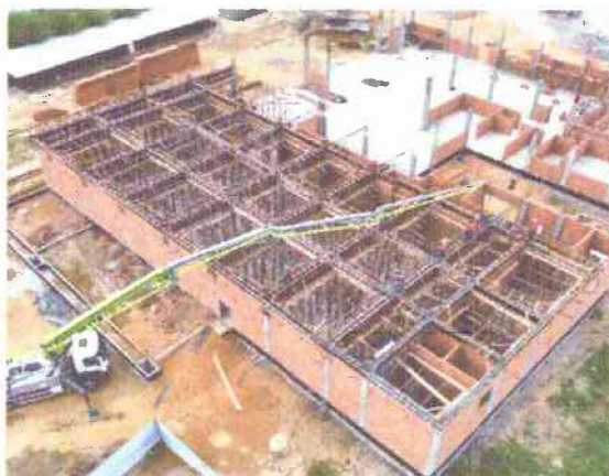
ALVENARIA DE VEDAÇÃO, FORMA, AÇO E CONCRETAGEM DAS VIGAS 1ª LAJE
