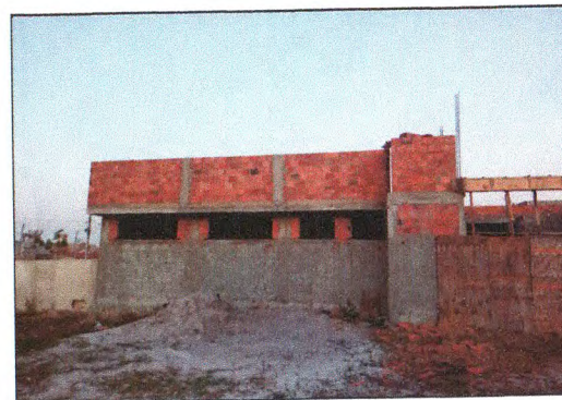
Visão da estrutura 06
