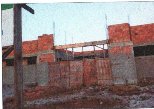
Visão da estrutura 05
