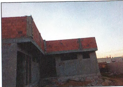
Visão da estrutura 02
