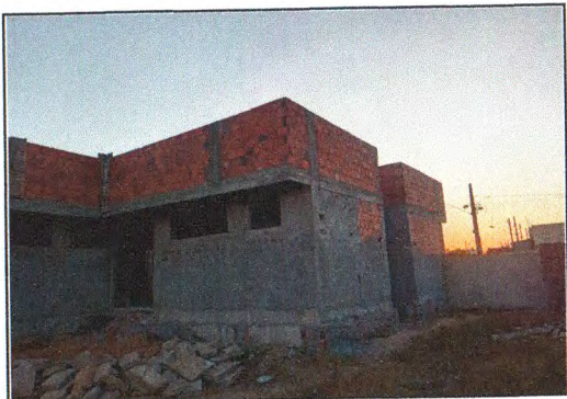
Visão da estrutura 01
