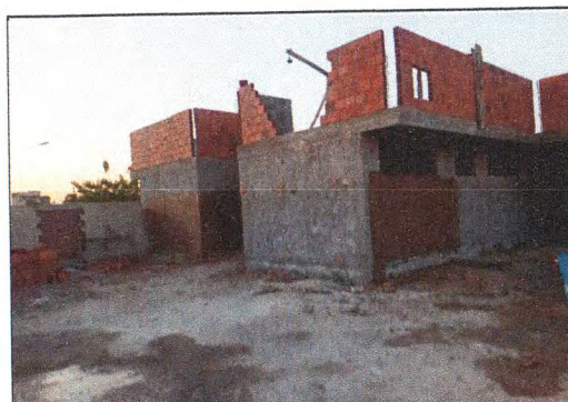
Detalhe do reboco 02
