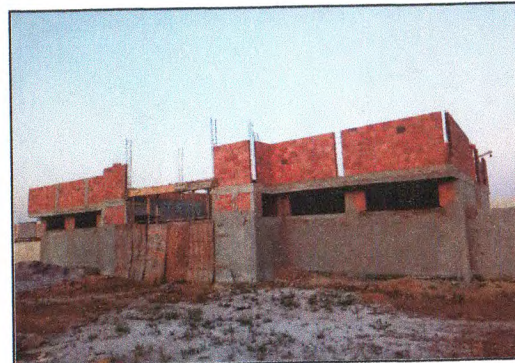
Visão da estrutura 03
