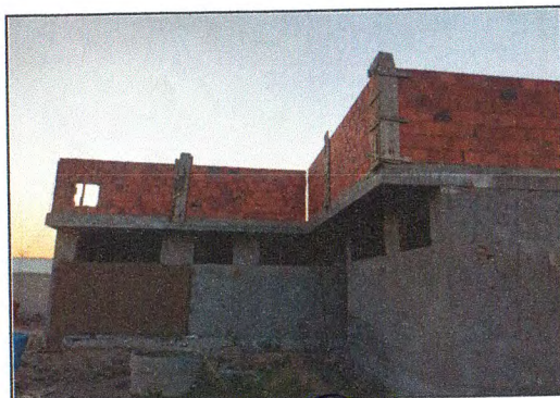
Detalhe do reboco 01
